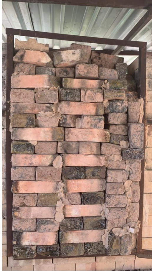
Görsel 31: Soda Fırının Kapağının Örülmesi 07.09.2024
