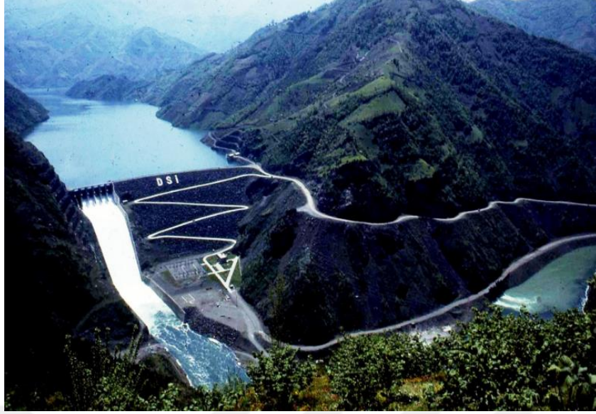
Şekil 4.8. Hasan Uğurlu Barajı'nın görüntüsü
