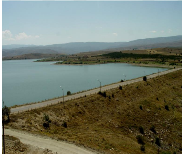
Şekil 4.3. Gölova Barajı’nın görüntüsü
