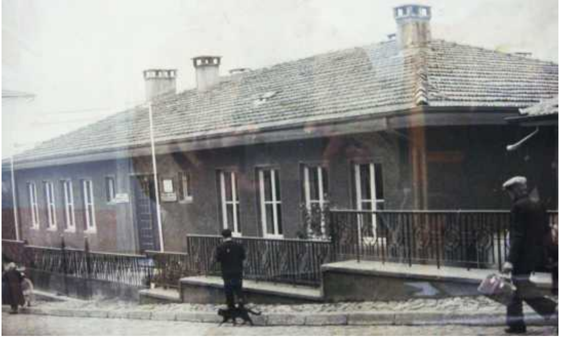
Şekil 3.35. Verem Dispanseri binasının giriş cephesi (Dispanser arşivi)
