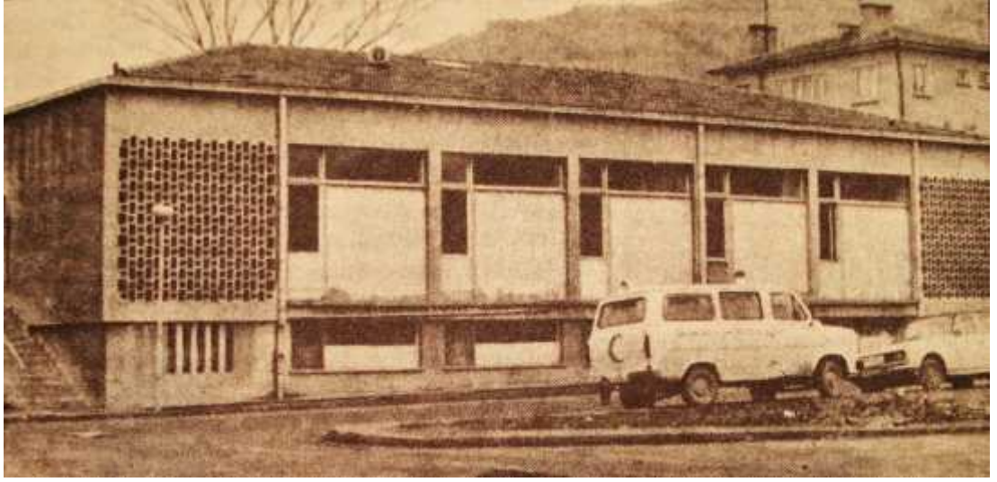
Şekil 3.52. 1980 yılından önce hemşire lojmanı, 1983 yılına kadar SSK Kreş Binası olarak kullanılan bina (Kocaeli Gazetesi, 21 Ocak 1983).
