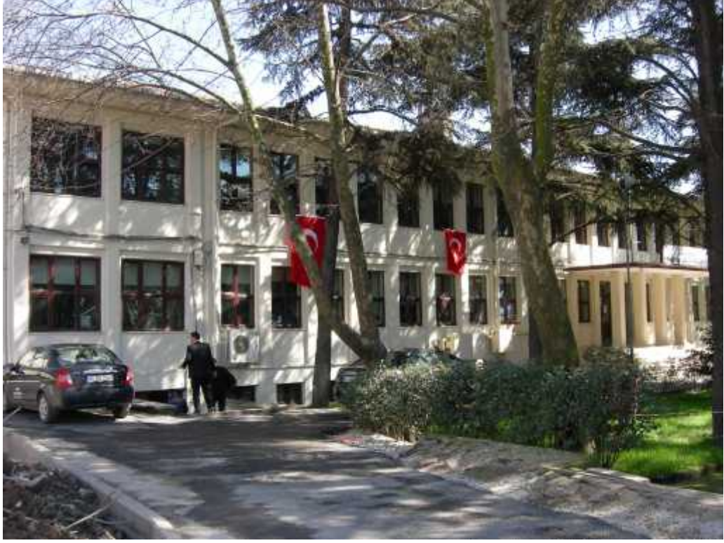
Şekil 3.62. 1952 yılında inşa ettirilen Adliye Binası, 2010 (Oya Şenyurt arşivi)
