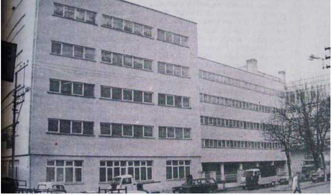
4.41. Tekel Binası'nın 1966 yılında tamamlanan blokları (Kocaeli Gazetesi, 14 Mart 1987)
