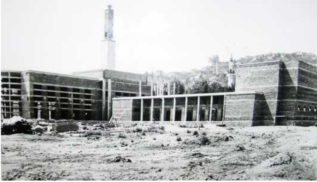
Şekil 3.12. Halkevinin inşaat çalışmaları, 1940 (Devlet Arşivleri Genel Müdürlüğü Cumhuriyet Arşivi, Fon kodu: 490.01 Yer kodu: 1749.1101.1)
