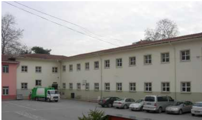
Şekil 3.43. L biçimindeki yapının arka cephesi ve sol başta sonradan eklenen bölüm, 2010 (Oya Şenyurt arşivi)
