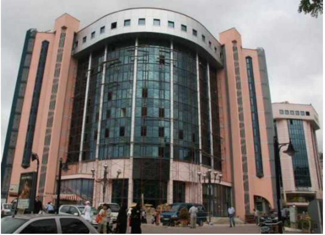
Şekil 4.26. Bugünkü “İzmit Belediyesi” hizmet binası (URL-12)
