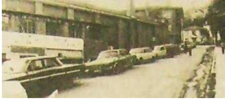
Şekil 4.49. Oğuz Sineması'nın giriş cephesi, 1987 (Kocaeli Gazetesi, 5 Eylül 1987)
