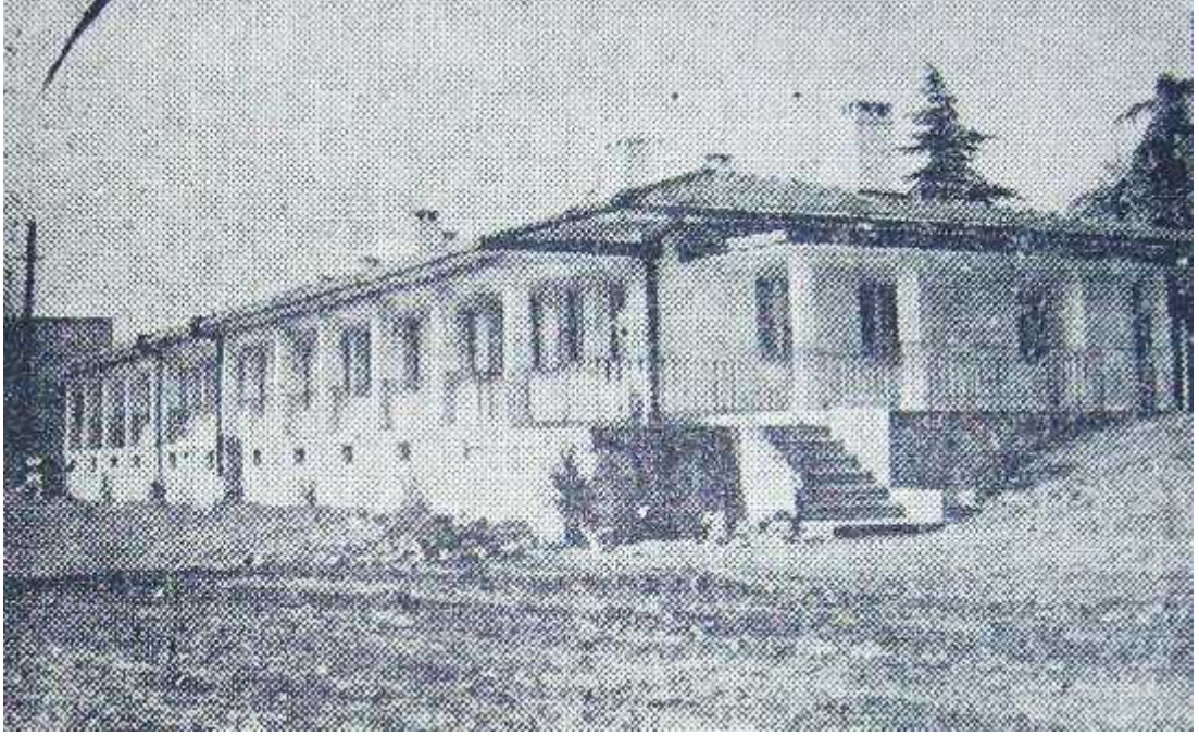
Şekil 4.23. Seka Kreş Binası giriş kısmı, 1958 (Hürsöz Gazetesi, 20 Eylül 1958)
