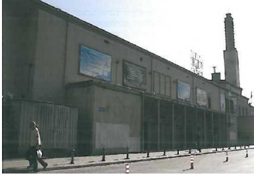
Şekil 3.24. Halkevinin arka cephesinden bir görüntü, 2010 (Oya Şenyurt arşivi)
