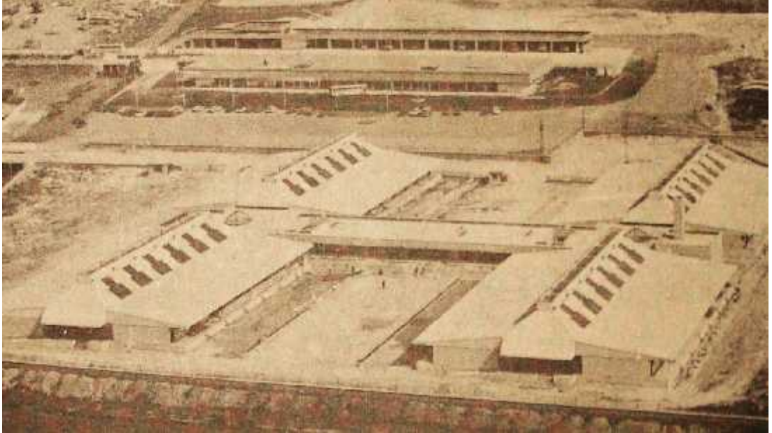
Şekil 4.12. 42 Evler mevkiinde inşa edilen bugünde mevcut olan hal binası, 1983 (Kocaeli Gazetesi, 14 Şubat 1983)
