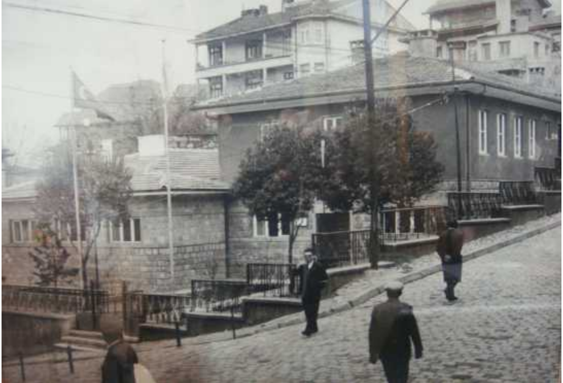
Şekil 3.36. Verem Dispanseri sol cephesi (Dispanser arşivi)
