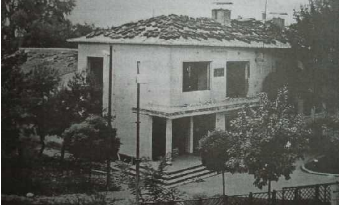
Şekil 4.8. 2006 yılında Seka İlköğretim Okulu’nun yıkım aşaması (Kocaeli Gazetesi, 12 Ocak 1991)
