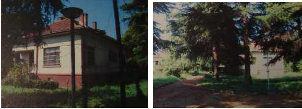
Şekil 3.27. Bodrum ve zemin kattan oluşan çift daireli işçi evleri (Osman Nuri Cebe arşivi)
