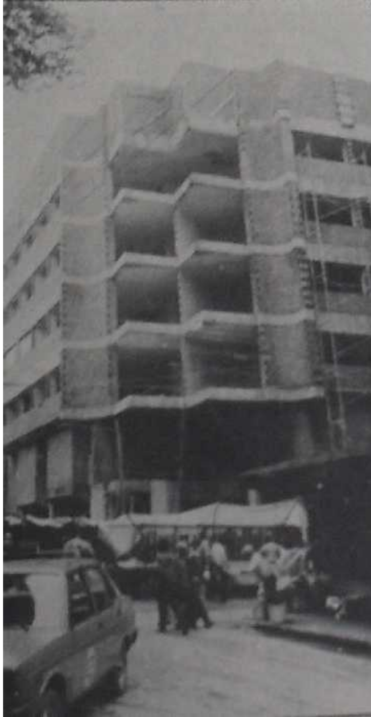
Şekil 4.39. 1992 yılında tamamlanan, günümüzde mevcut olan Kızılay Binası'nın inşaat çalışmaları (Kocaeli Gazetesi, 29 Haziran 1991)
