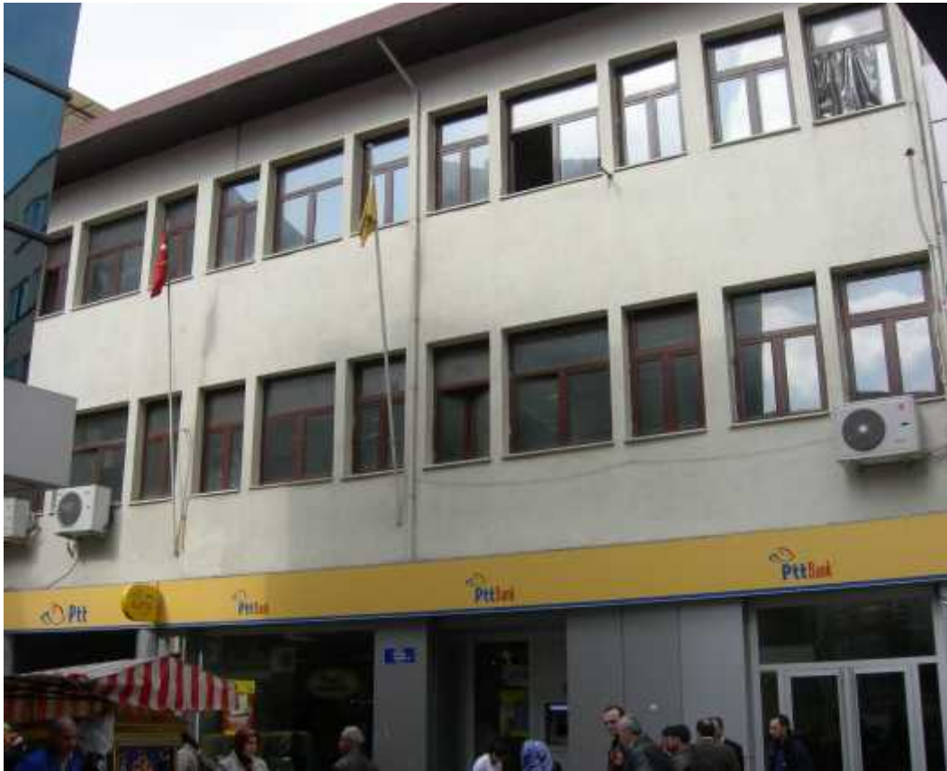
Şekil 3.71. PTT Binası'nın giriş cephesinden bugüne ait bir görüntü, 2010 (Oya Şenyurt arşivi)
