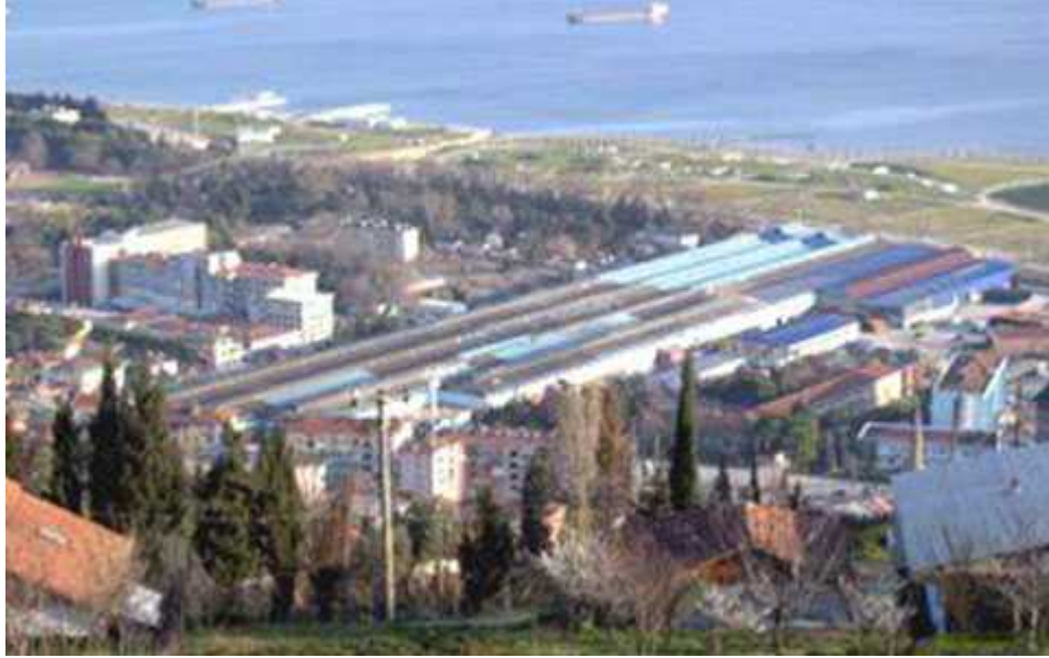
Şekil 3.85. Mannesmann Boru Fabrikası, 2011 (Kocaeli Gazetesi, 28 Mart 2011)
