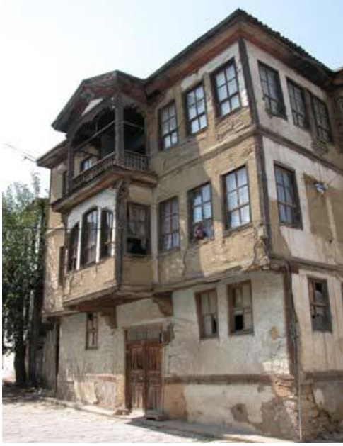
Fenerli Ev'in güney cepheden görünümü
