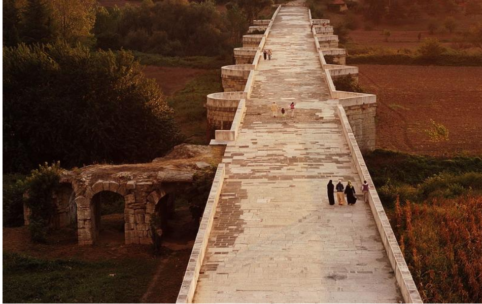
Şekil 3.5. Justinianos köprüsü üst görünüşü (URL-9)
