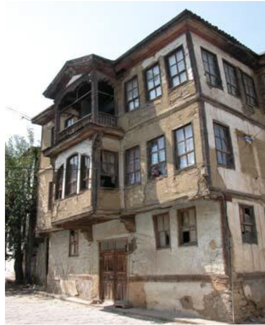
Fenerli Ev'in güney cepheden görünümü
