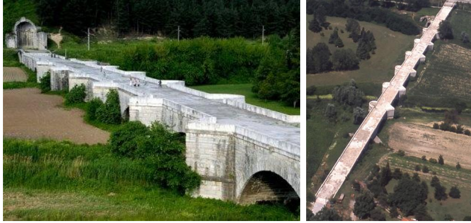
Şekil 3.4. Justinianos köprüsü yan görünüşleri (URL-8)
