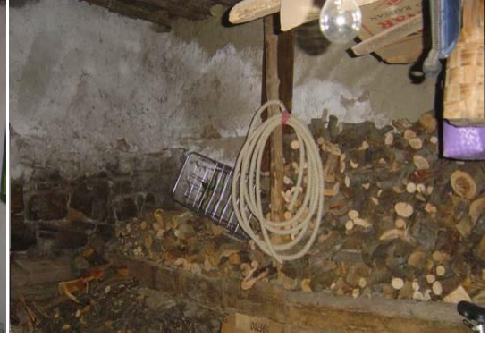
Özgün işlevli ahır olan depo, Ahşap dikme ve taş yalak
