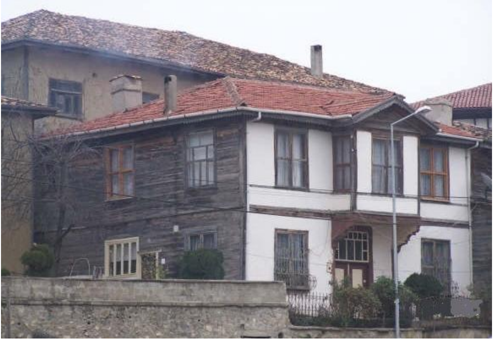
Ön Cephe Görünüşü
