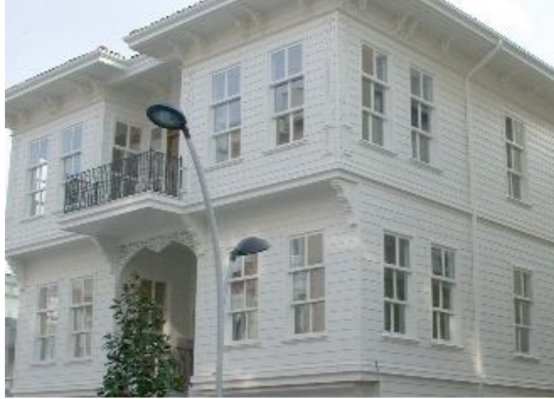
Şekil 3.12. Cevat Bey Konağı (2012 deki durumu)
