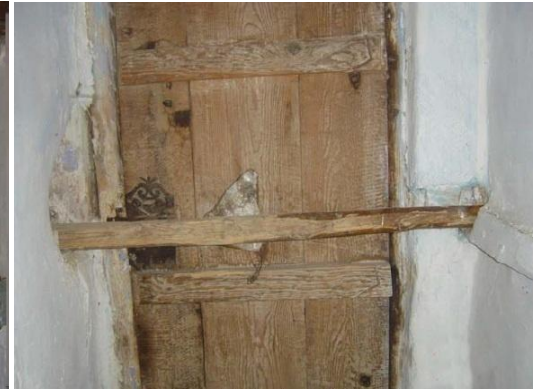
Kat giriş kapısı ve kilit düzeneği
