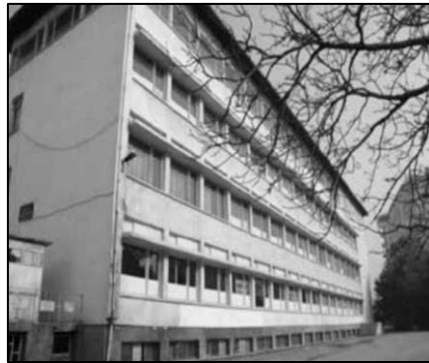
Şekil 5.56. 1965 yılından itibaren kullanılmaya başlayan ve öğretim binası olarak kullanılan İmam Hatip Okulu ek binası (Erkoç, 2018)
