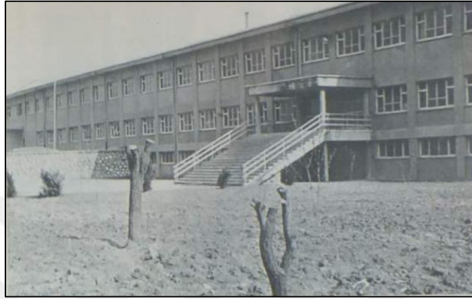
Şekil 5.78. Yeni yapılan Erkek Sanat Enstitüsü (1967 Çorum İl Yıllığı)
