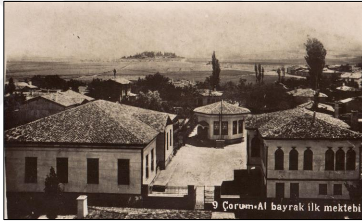
Şekil 5.67. Albayrak İlkokulu eski binası (Atatürk Kitaplığı Sanal Arşivi)
