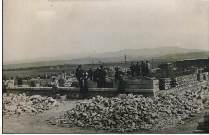
Şekil 5.44. Çorum ortaokulu inşaatı sürerken (Yiğit, 2017)
