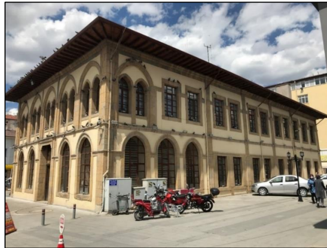
Şekil 5.9. Bugün de Belediye binası olarak kullanılan yapının günümüzdeki durumu
