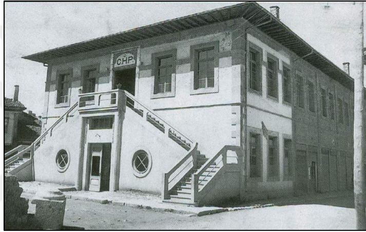
Şekil 5.3. Kütüphane binasına 1935'te yapılan ekin 1950'lerdeki durumu (Yiğit, 2010)
