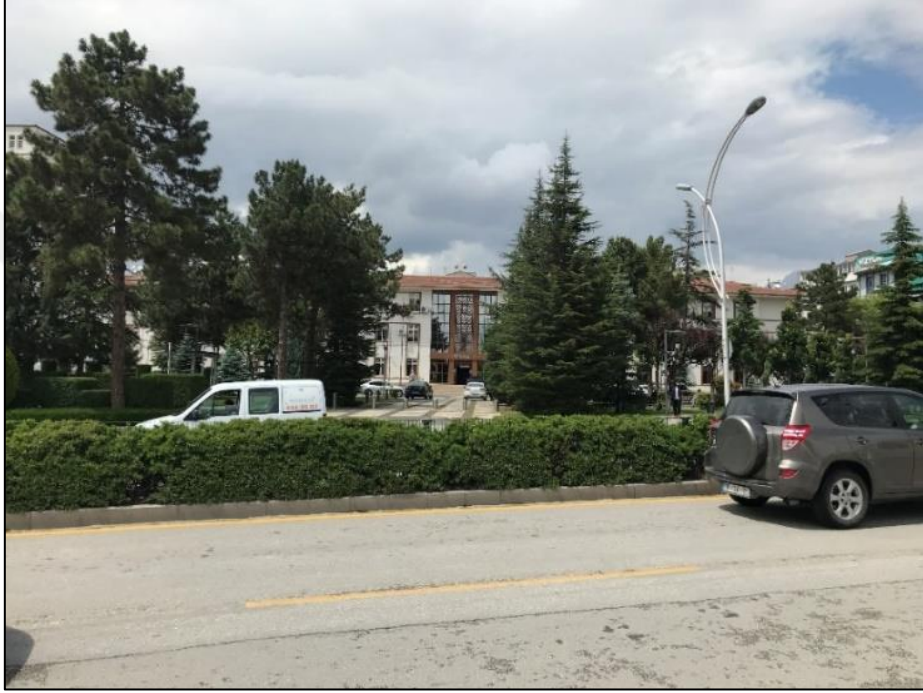
Şekil 5.19. Günümüzde (2021) Vilayet Binası olarak hizmet veren yapı
