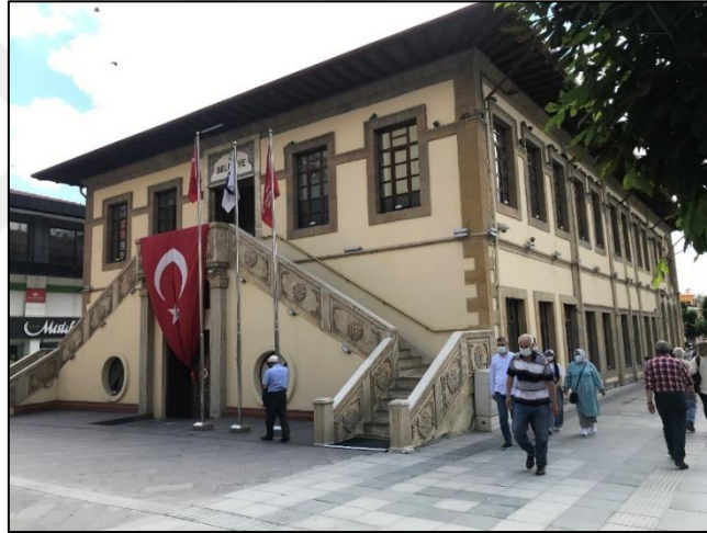
Şekil 5.8. Yapının günümüzdeki (2021) durumu
