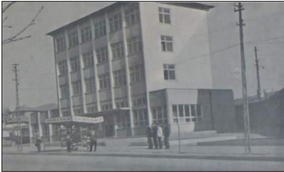
Şekil 5.37. Çorum Halk Eğitim binasının 1967 Çorum İl Yıllığındaki fotoğrafı
