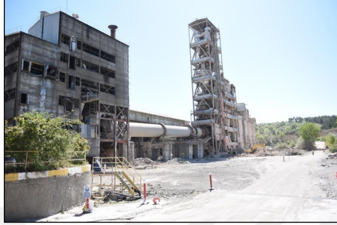
Şekil 5.114. Yıkımına başlanan Çorum Çimento Fabrikası (Çorum Belediyesi Basın Arşivi, 2021)
