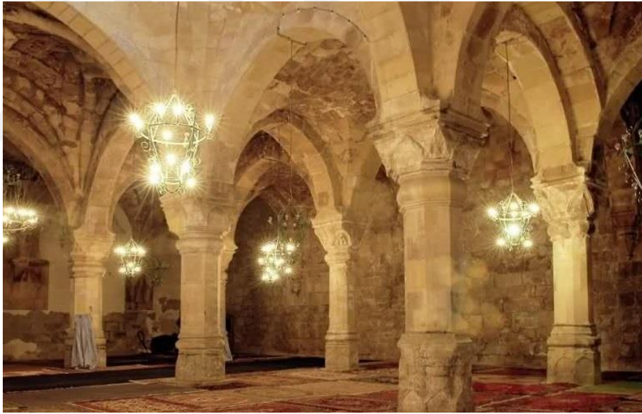
Resim 42: Yeniden işlevlendirmede, tesisat sisteminden aydınlatmaya yönelik bir müdahale örneği. Divriği Ulu Camii iç mekân görünüşü. [URL-35]
