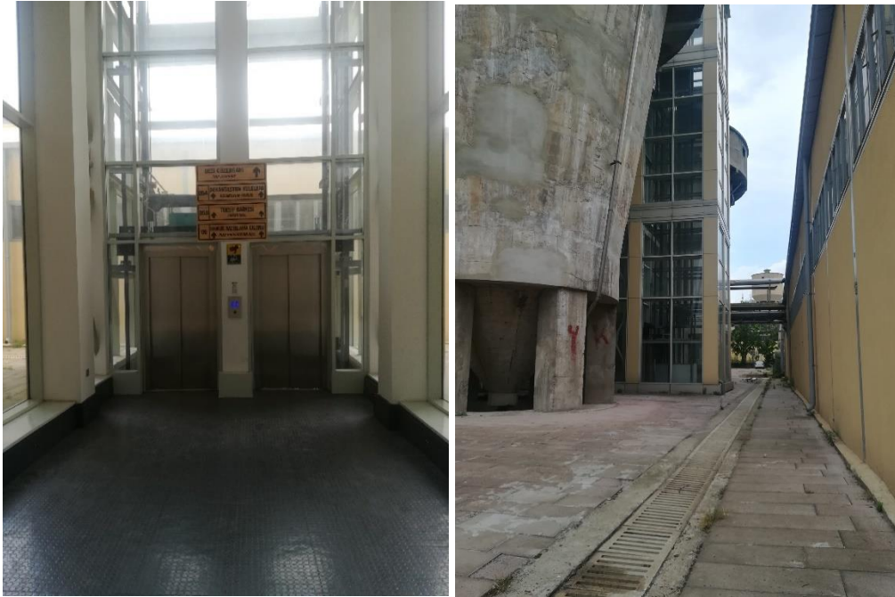
Resim 102: Müze içine sonradan eklenen asansör. (Kaynak: Yazarın fotoğraf arşivinden alınmıştır.)
