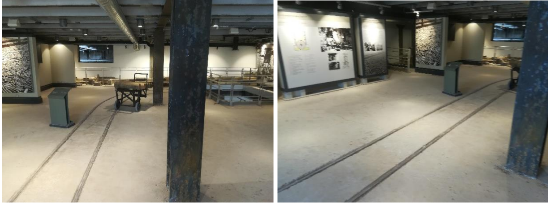
Resim 60: Korunan beton zemin döşemesi ve raylar. (Kaynak: Yazarın fotoğraf arşivinden alınmıştır.)
