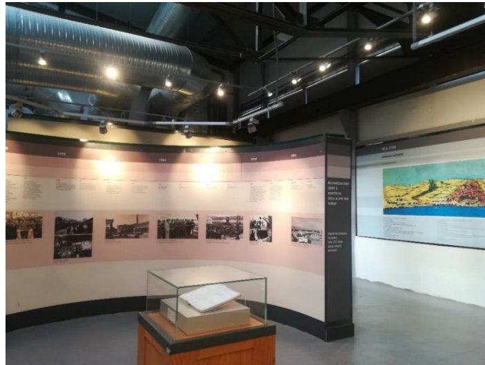
Resim 111: Müze içinden kullanılan raylı aydınlatma sistemi örneği. (Kaynak: Yazarın fotoğraf arşivinden alınmıştır.)
