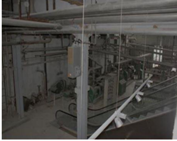
Resim 101: Müze içine eklenen yürüyen merdivenin, yapım aşamasından bir görsel. (Kaynak: Yazarın fotoğraf arşivinden alınmıştır.)
