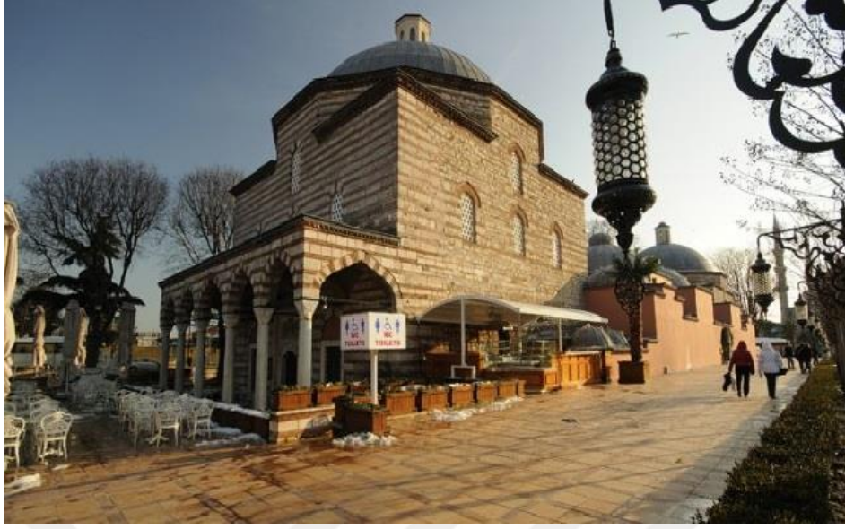
Resim 34: Ayasofya Haseki Hürrem Sultan Hamamı'nın 2015 yılına ait dış görünüşü. [URL-30]
