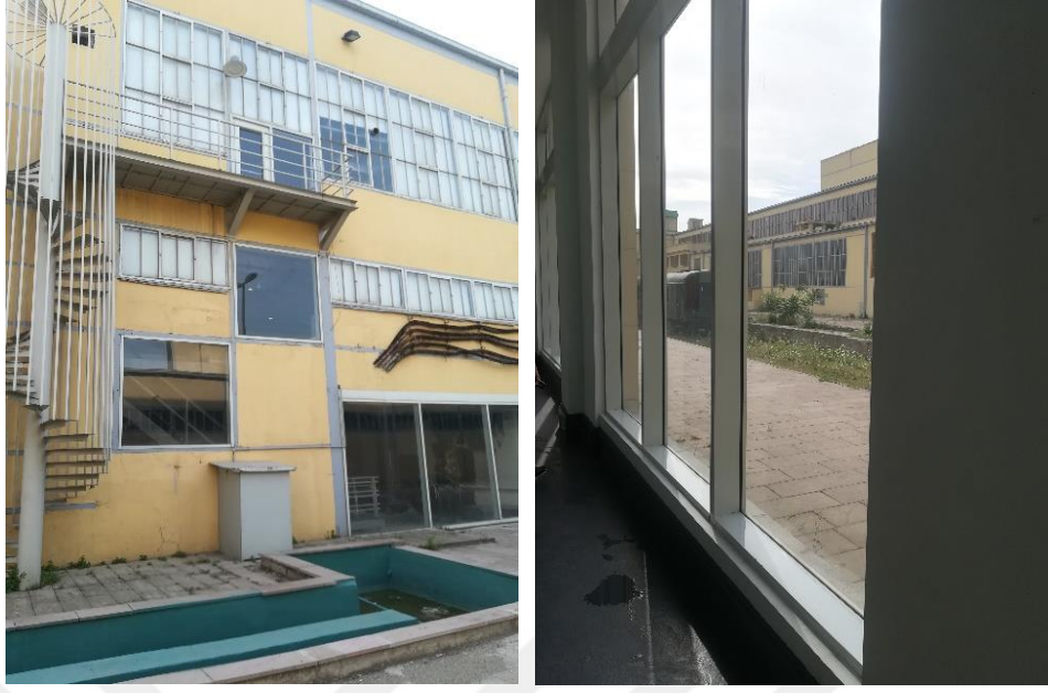
Resim 133: Orijinal halleri korunmamış, yenilenmiş pencere doğraması örnekleri (Kaynak: Yazarın fotoğraf arşivinden alınmıştır.)
