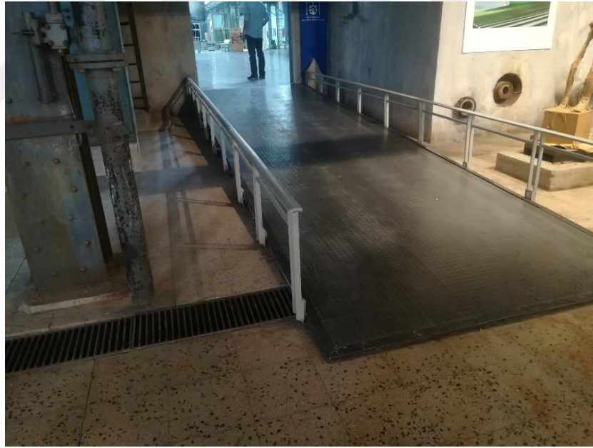
Resim 62: İlave edilen rampa bölümünün altında ve çevresinde, korunan seramik döşeme örneği. (Kaynak: Yazarın fotoğraf arşivinden alınmıştır.)
