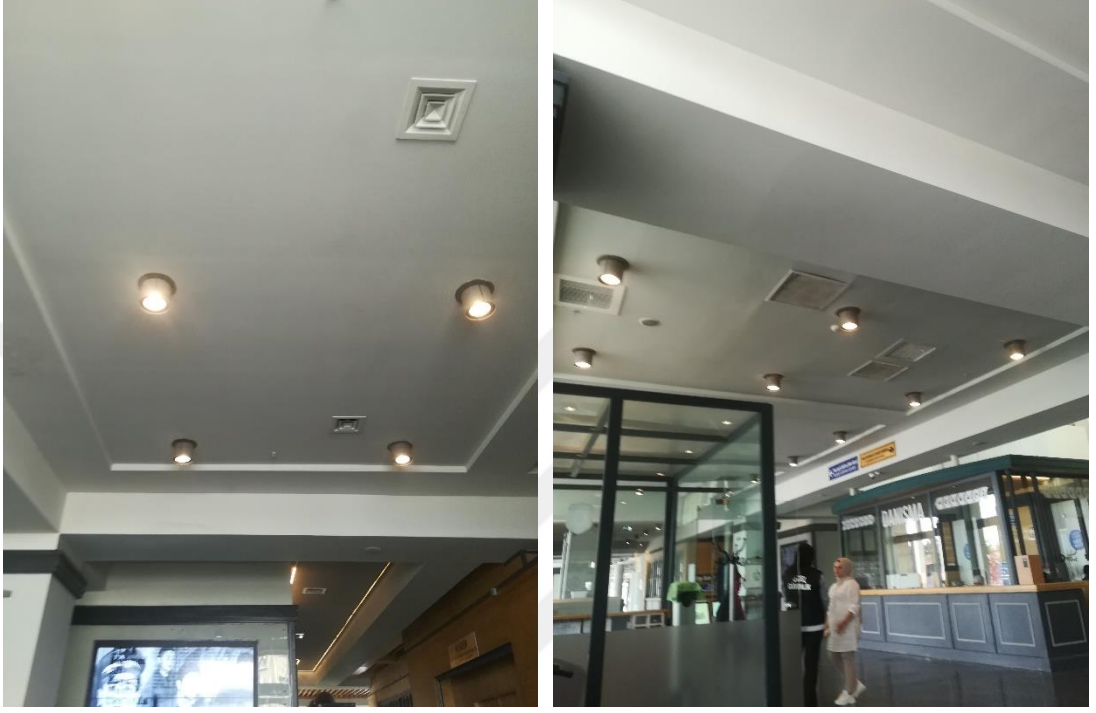
Resim 137: Kartonlu alçı plaka ile kapatılan tavan örnekleri. (Kaynak: Yazarın fotoğraf arşivinden alınmıştır.)
