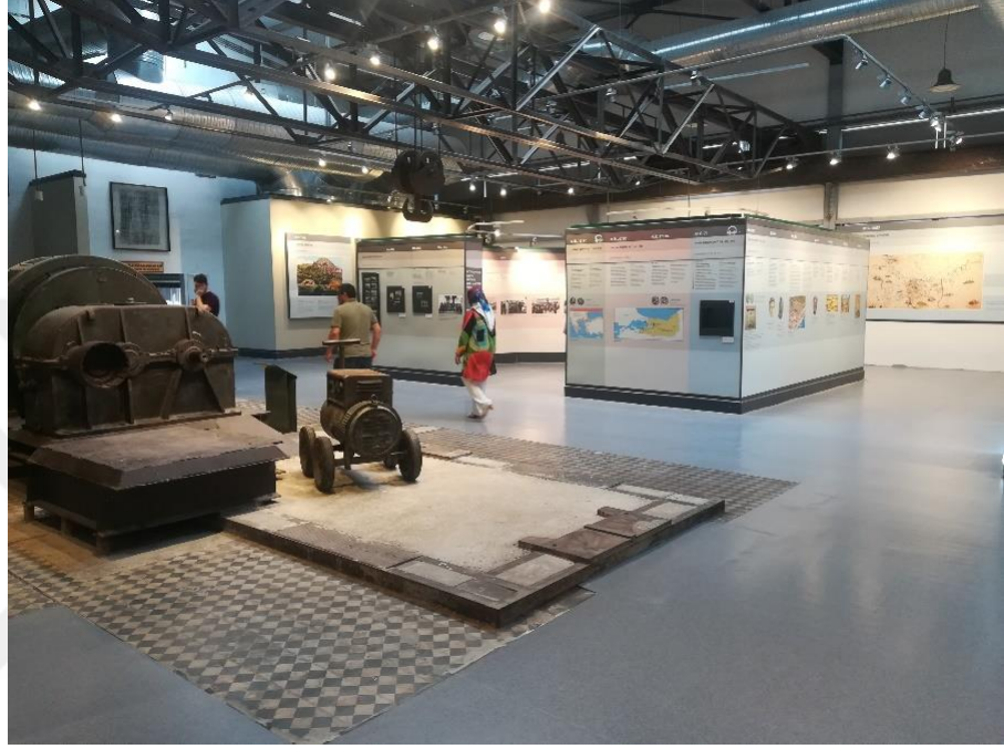
Resim 93: Türbin dairesi içerisinde yer alan, metal karkas ve kontraplaktan oluşan bölücü örnekleri. (Kaynak: Yazarın fotoğraf arşivinden alınmıştır.)
