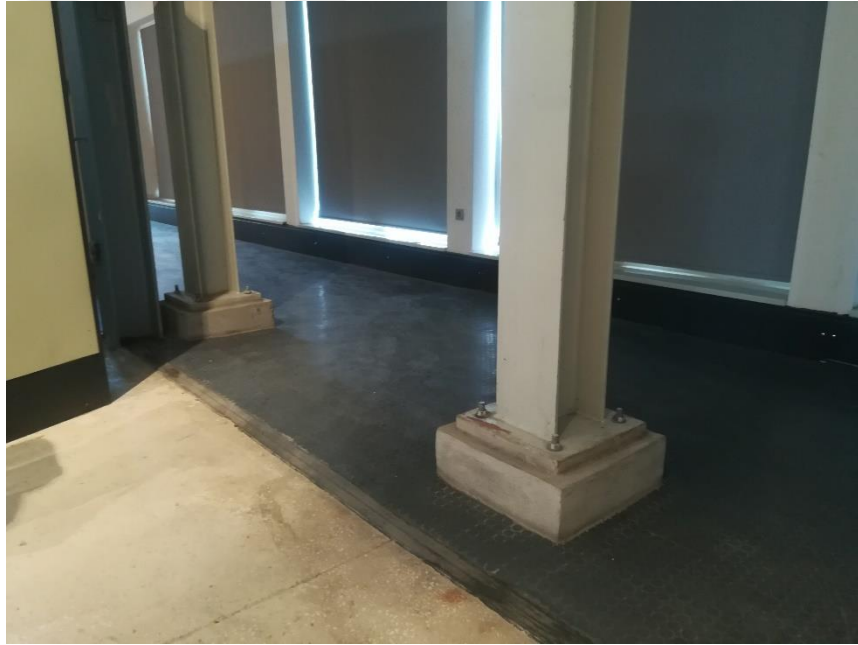
Resim 104: Müze içinde, yeni beton ayak eklenmiş kolon örnekleri. (Kaynak: Yazarın fotoğraf arşivinden alınmıştır.)
