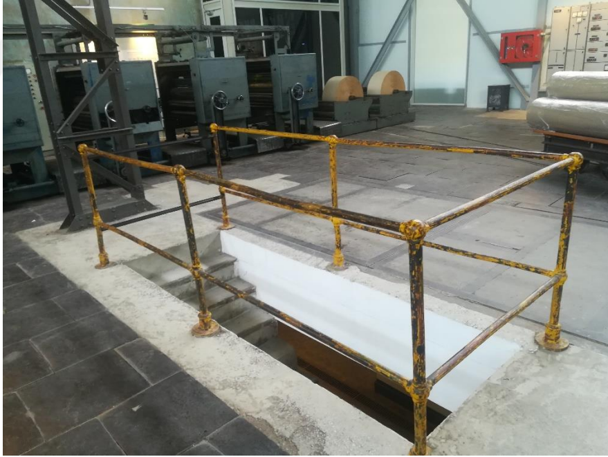
Resim 68: Dökme demir döşeme ve beton döşeme ile mevcut merdivenin korunması. (Kaynak: Yazarın fotoğraf arşivinden alınmıştır.)
