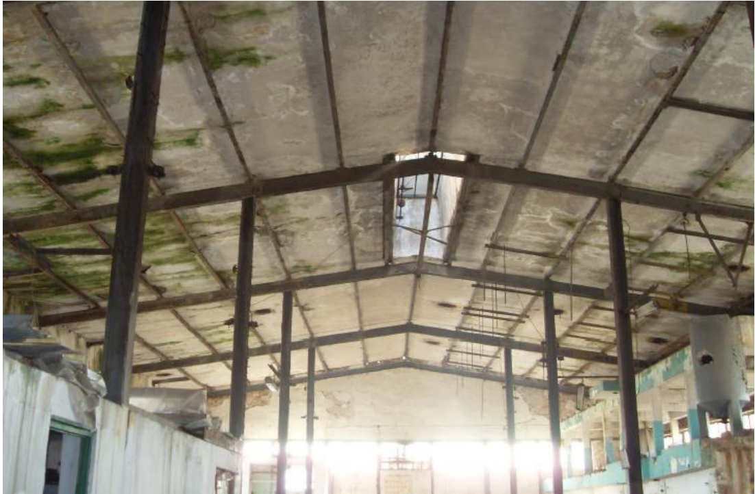
Resim 57: Hamur bölümü ikinci katından, çatı ve kiriş sistemini gösteren bir görünüş. (Kaynak: Kartal, 2009: s.75)
