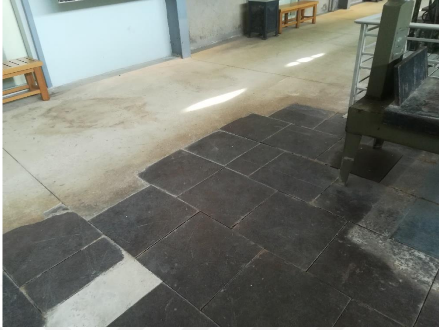
Resim 67: Dökme demir zemin döşemesinin korunan bir bölümü. (Kaynak: Yazarın fotoğraf arşivinden alınmıştır.)
