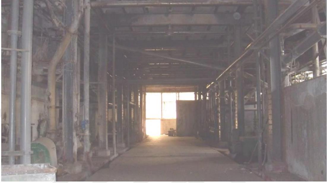
Resim 56: Hamur bölümü zemin katından bir iç mekan görünüşü: Çelik konstrüksiyon taşıyıcı sistem görölmektedir. (Kaynak: Kartal, 2009: s.73)
