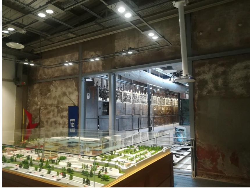
Resim 103: Müze içinde, kısmen yıkılmış bir duvar örneği. (Kaynak: Yazarın fotoğraf arşivinden alınmıştır.)
