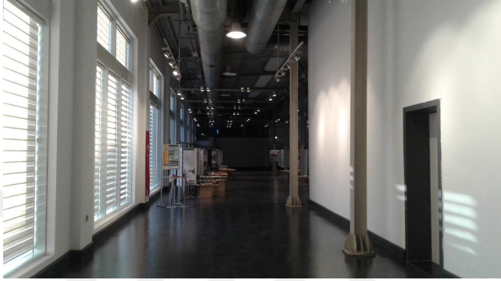
Resim 135: Epoksi zemin döşemesi. (Kaynak: Yazarın fotoğraf arşivinden alınmıştır.)
