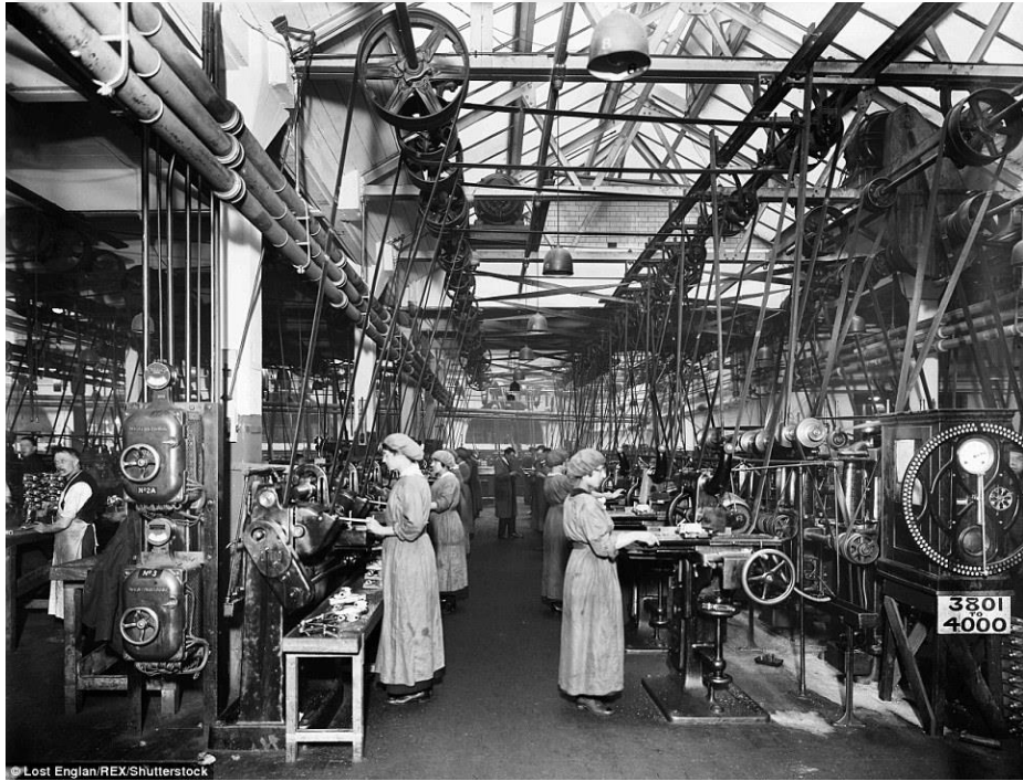
Resim 13: Çatıda çelik konstrüksiyon kullanılmış bir fabrikanın iç mekânı.[URL-11]
