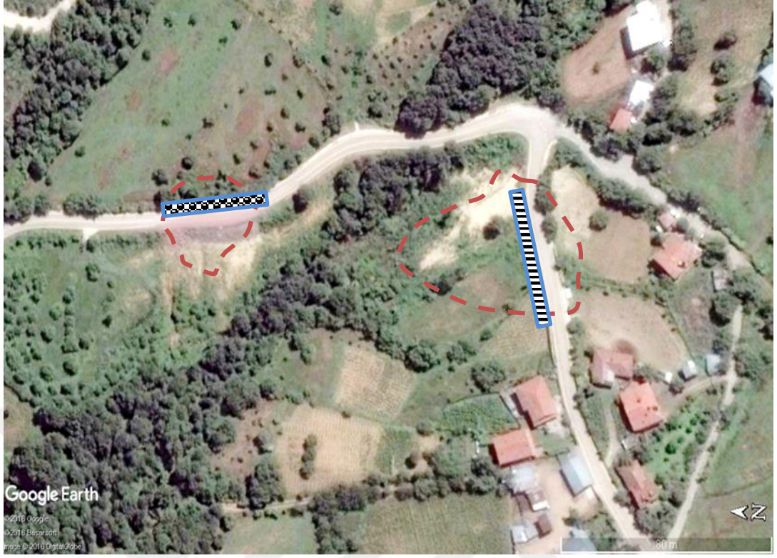
Şekil 8.25. Yol güzergâhında meydana gelen heyelan ve alınan önlemler (mavi; istinat yapıları, kırmızı; heyelan alanı)
