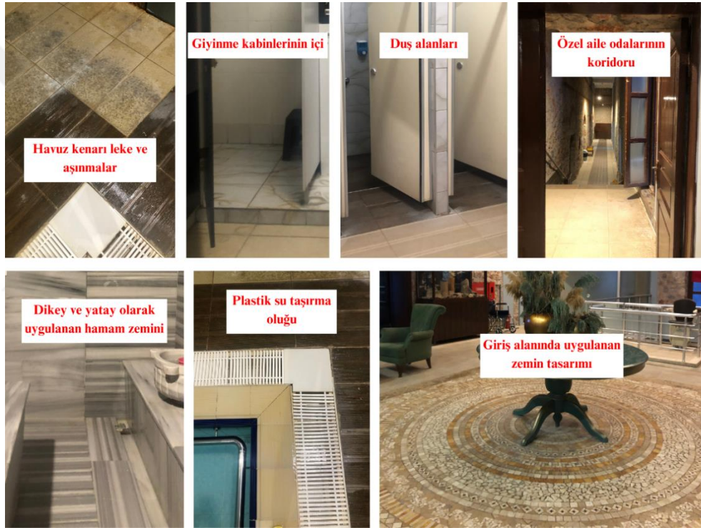
Resim 33: Gölçük Belediyesi Yazlık Ilıca havuz binası zemin detayları (Yazar tarafından 25.11.2024-25.12.2024 tarih aralığında fotoğraflanmıştır).
