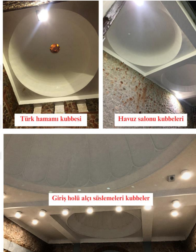
Resim 38: Gölçük Belediyesi Yazlık Ilıca havuz binası kubbe detayları (Yazar tarafından 24.12.2024 tarihinde fotoğraflanmıştır).
