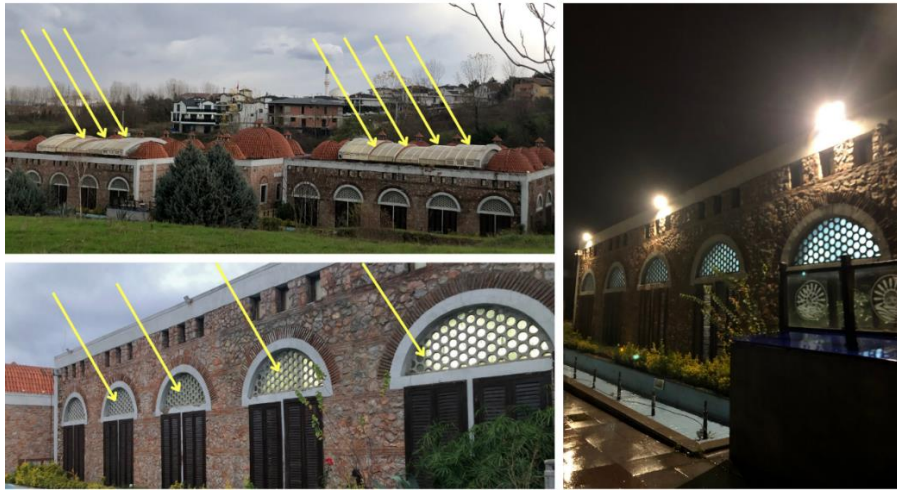
Resim 30: Gölçük Belediyesi Yazlık Ilıca havuz binası cephede yararlanılan doğal ve yapay aydınlatma detayları, sarı oklar güneş ve gün ışığını simgelemektedir (Yazar tarafından 25.11.2024-25.12.2024 tarih aralığında fotoğraflanmıştır).
