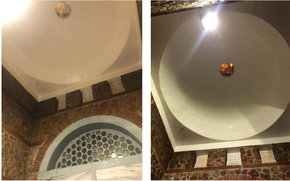
Resim 29: Gölcük Belediyesi Yazlık Ilıca kadınlar bölümü Türk hamamı tavanı ışıklık detayı (Yazar tarafından 17.09.2023 tarihinde fotoğraflanmıştır).
