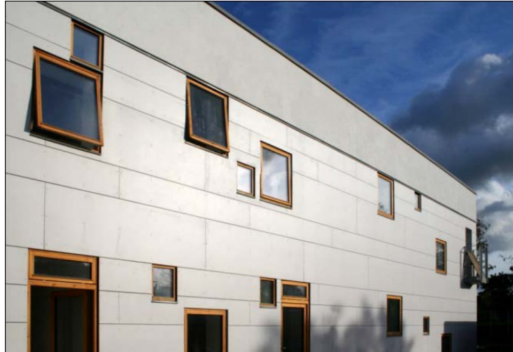
Şekil 5.45: Anaokulunun kuzey cephesinden görünüm ( http-32 )
