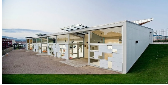
Şekil 5.120: La Cabanya sınıf bloğu cephesi (http-43)
