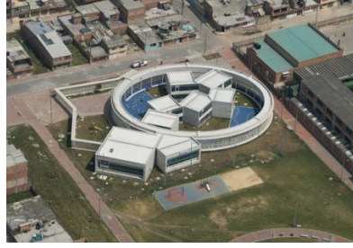
Şekil 5.102: Anaokulunun kare modüllerden oluşumu ve şematik gösterimi (http-40)
