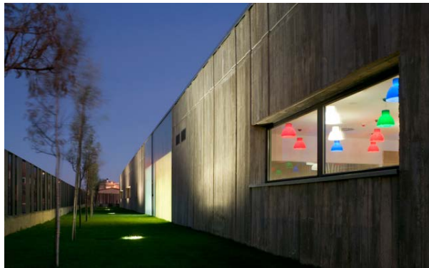
Şekil 5.34: Santa Isabel Anaokulu kuzey cephesi görünümü (http-30)
