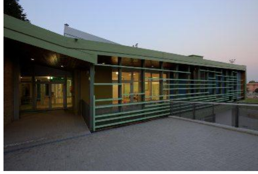
Şekil 5.68: Barbapapa Anaokulu cephesi (http-35)
