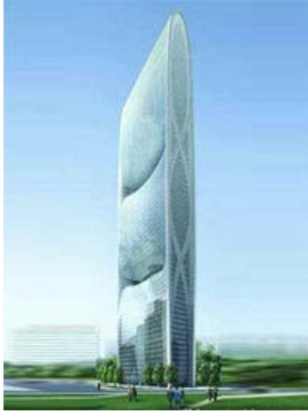
Şekil 3.8: Pearl River Kulesi ( http-9 )
