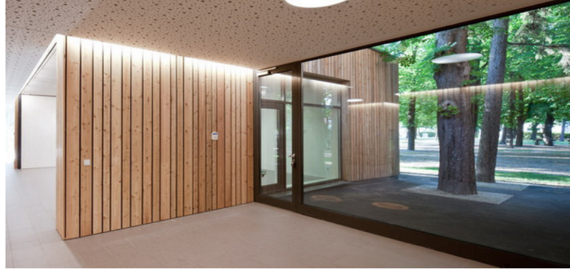
Şekil 5.112: Dış mekânla bütünlüğü sağlamak ve doğal ışıktan yararlanabilmek için yere kadar camlı tasarlanan cephe (http-42)
