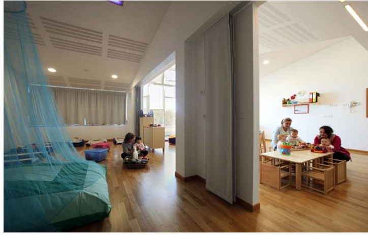
Şekil 5.70: Hareketli bölücü duvarlar ( http-35 )
