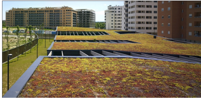
Şekil 5.24: Yeşil çatı görünümü (http-29)
