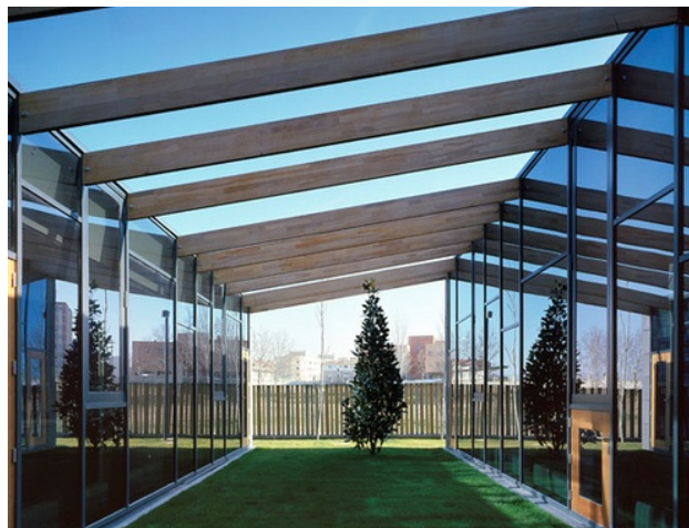
Şekil 5.28: Ahşap elemanlarla yapıda tamamlanmışlığın sağlanması (http-29)
