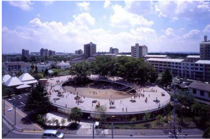
Şekil 5.8: Fuji Anaokulunun genel görünümü ( http-22 )
