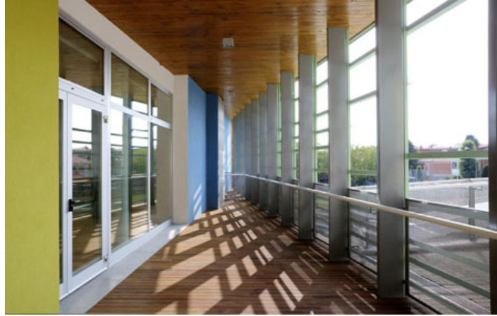
Şekil 5.73: Aile ve çocuk eğitim merkezinde tampon bölge olarak kullanılan koridor ve güneş kırıcılar (http-35)
