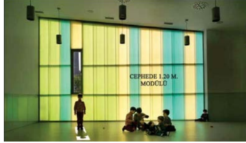
Şekil 5.82: Cephenin 1.20m ölçüye göre modüler tasarımı (http-36)
