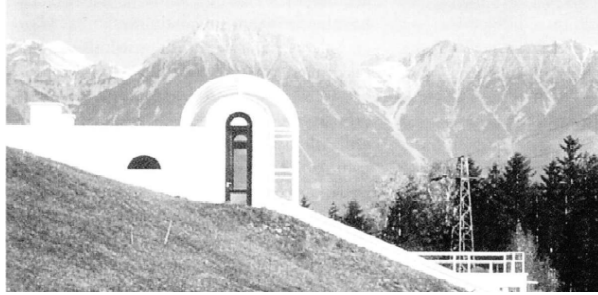
Şekil 3.3: Konut+Sergi Binası ( http-5 )
