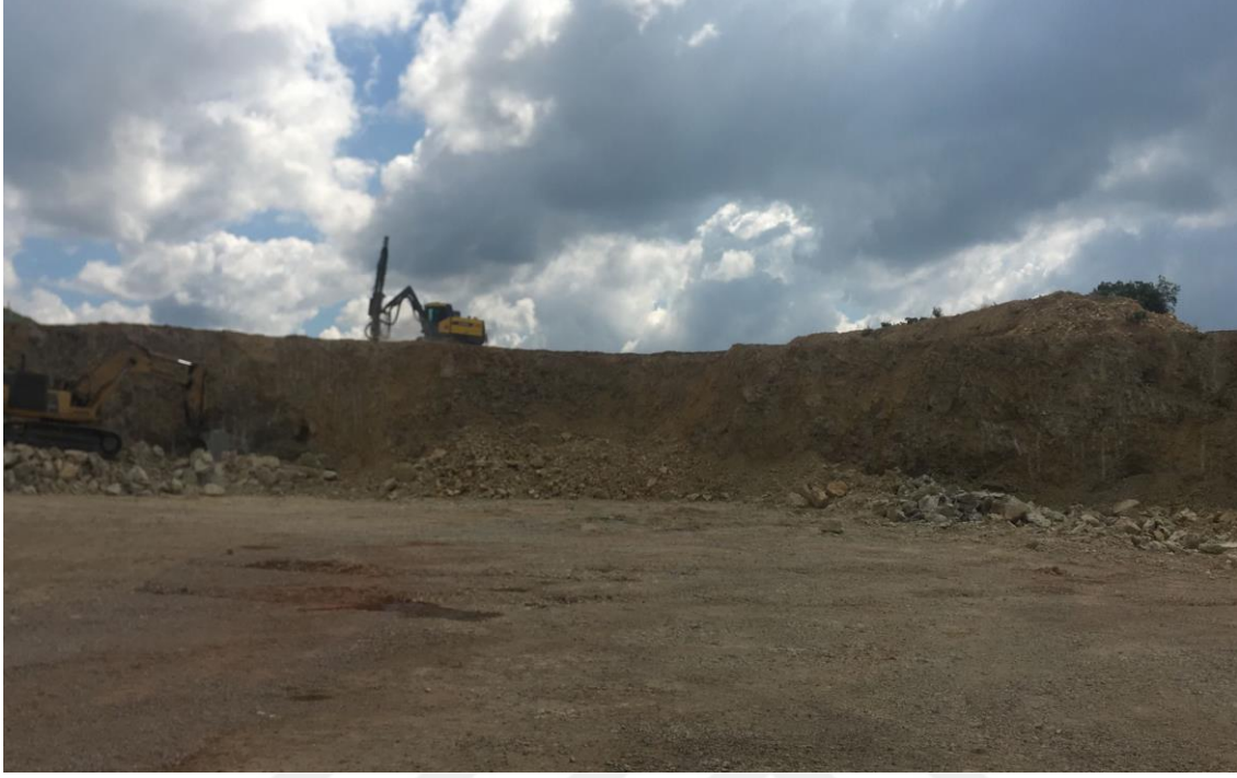
Şekil 5.3. İnceleme alanındaki kaya delici makinesinin arazide görünümü
