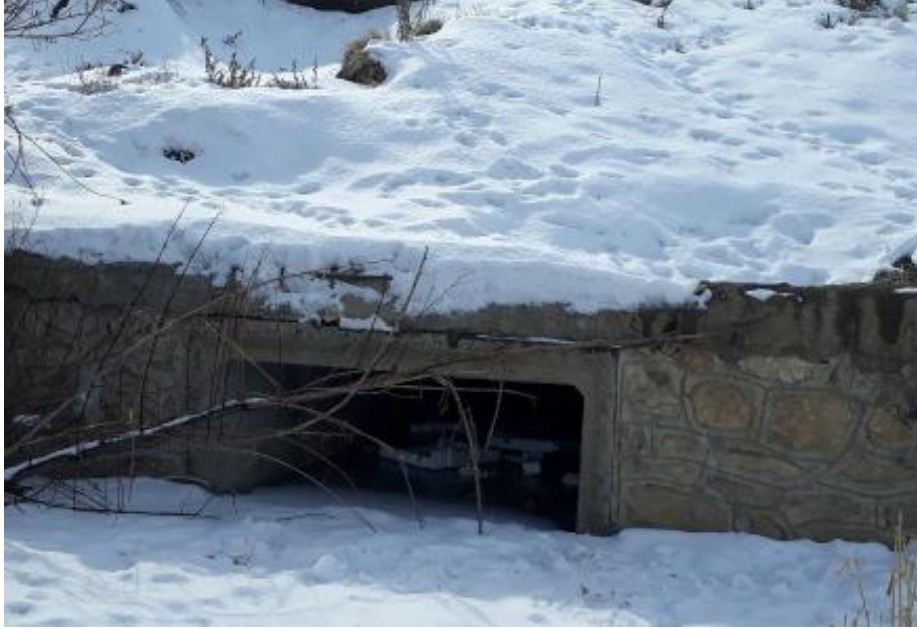
Şekil 4.15. Van Merkez5 Deresi Geçiş Yapısı
