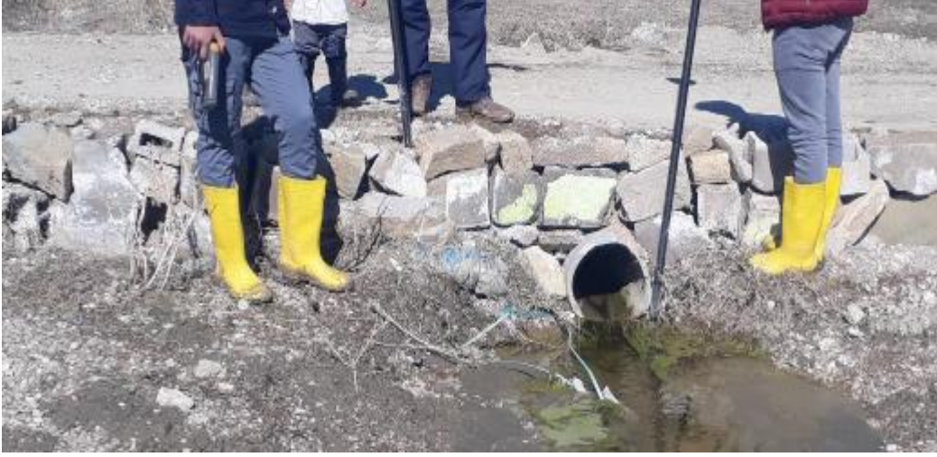
Şekil 4.12. Van Merkez3 Deresi Geçiş Yapısı
