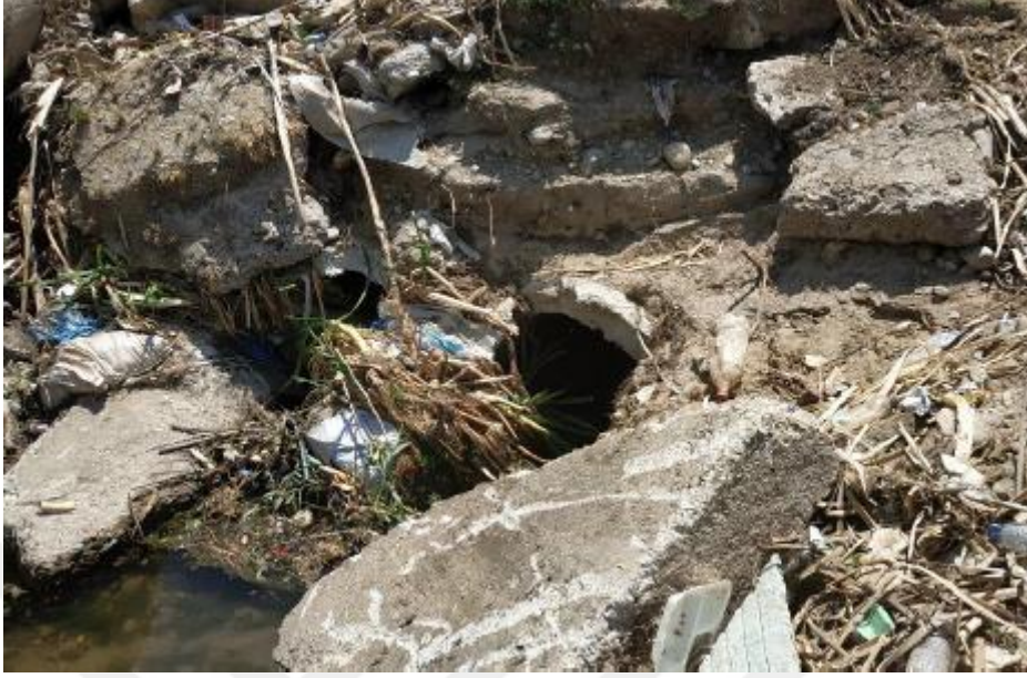
Şekil 4.58. Erciş5 Deresi Geçiş Yapısı
