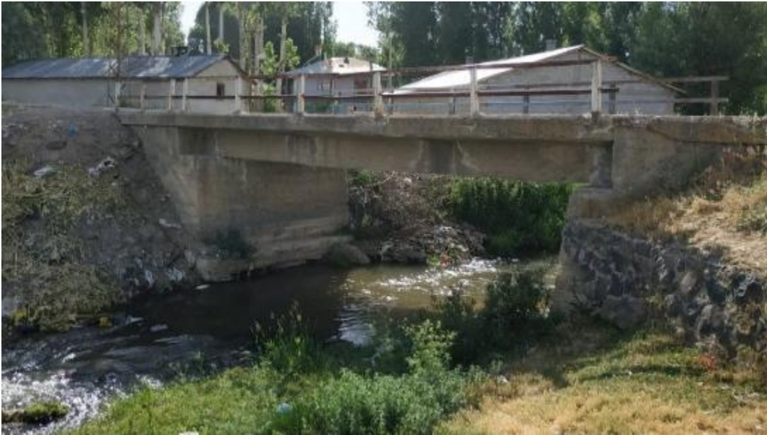
Şekil 4.39. Erciş2 Deresi Geçiş Yapısı
