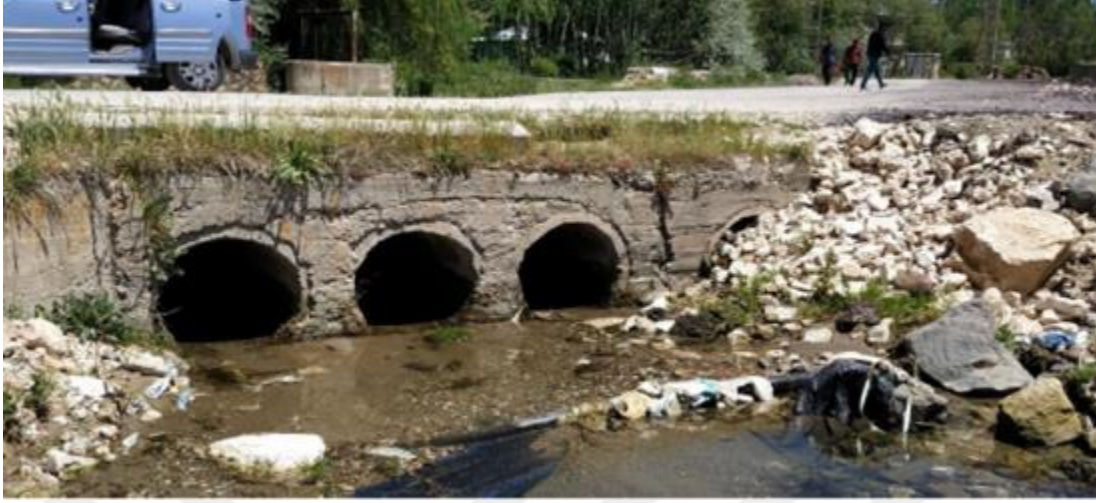
Şekil 4.50. Erciş4 Deresi Geçiş Yapısı
