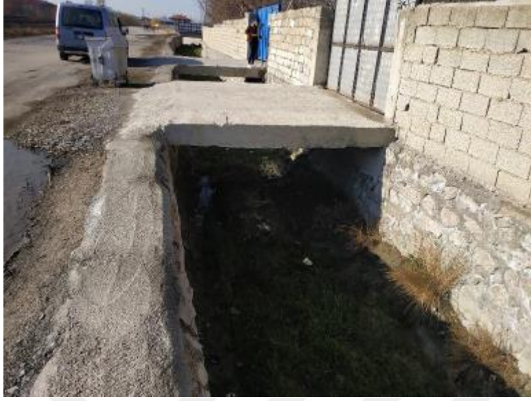
Şekil 4.8. Van Merkez2 Deresi Geçiş Yapısı
