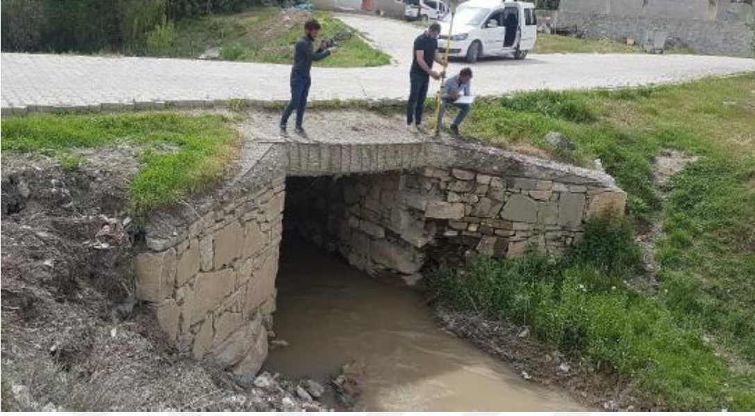
Şekil 4.20. Van Merkez6 Deresi Geçiş Yapısı
