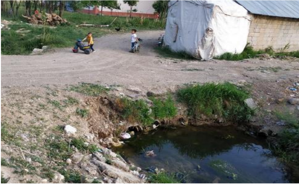
Şekil 4.33. Erciş1 Deresi Geçiş Yapısı
