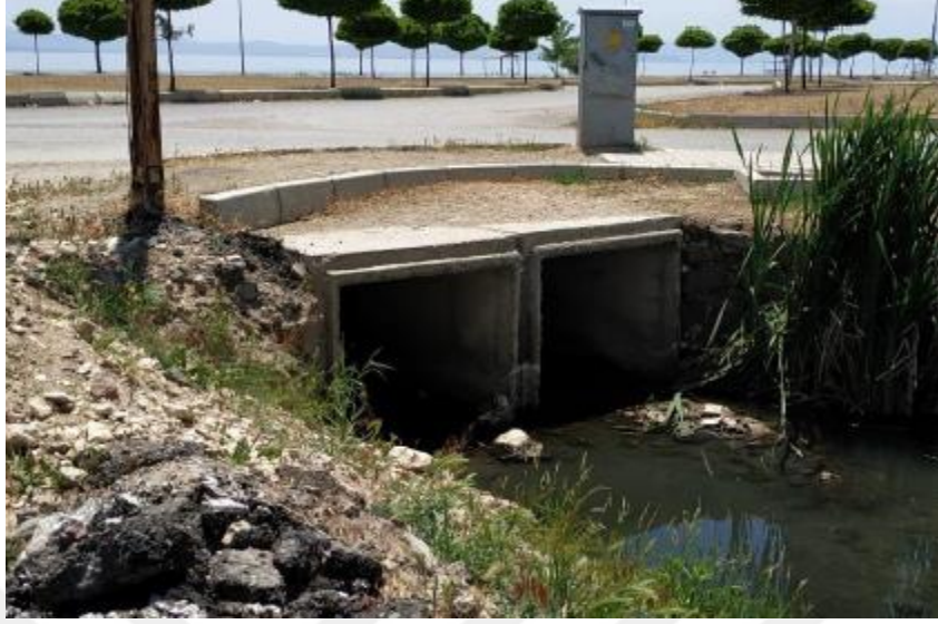
Şekil 4.54. Erciş5 Deresi Geçiş Yapısı
