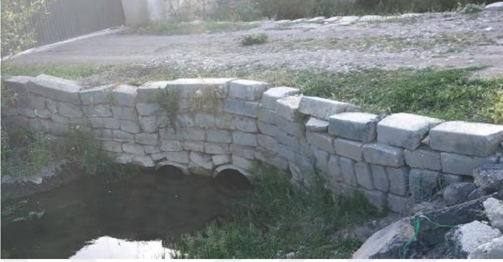
Şekil 4.34. Erciş1 Deresi Geçiş Yapısı
