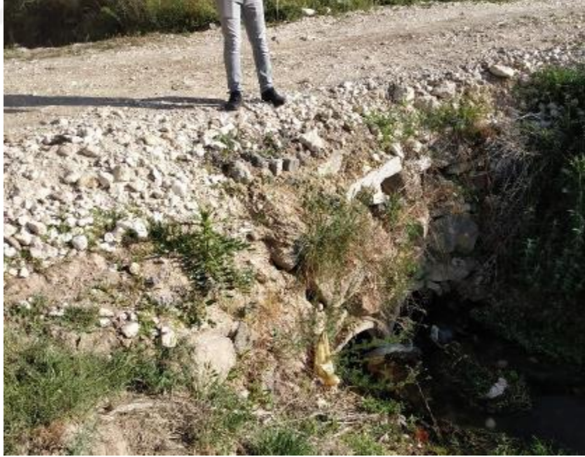
Şekil 4.35. Erciş1 Deresi Geçiş Yapısı
