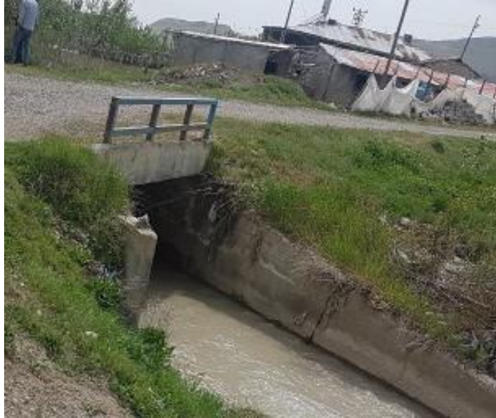
Şekil 4.23. Van Merkez6 Deresi Geçiş Yapısı
