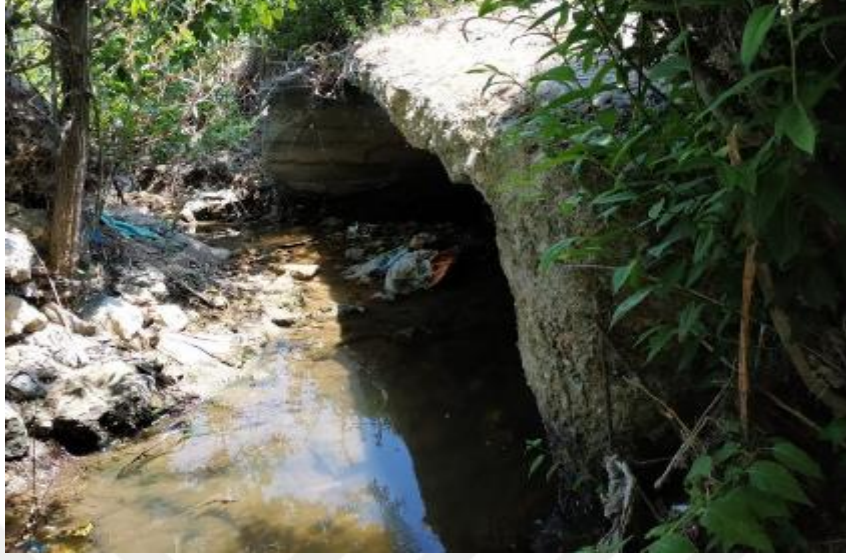
Şekil 4.56. Erciş5 Deresi Geçiş Yapısı
