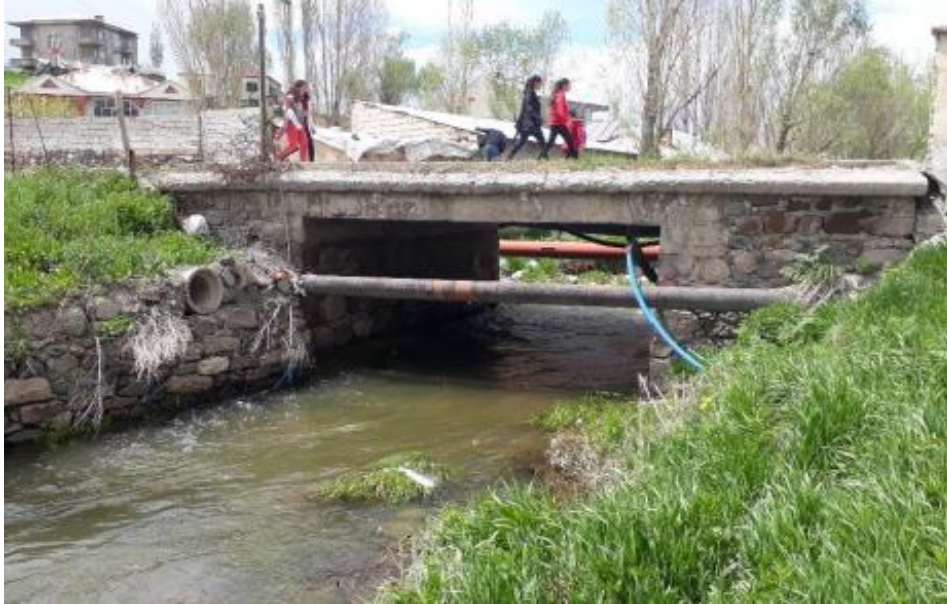
Şekil 4.25. Van/Çaldıran Kuskunkıran Deresi Geçiş Yapısı
