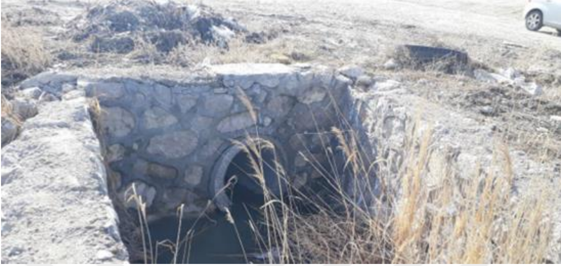
Şekil 4.14. Van Merkez4 Deresi Geçiş Yapısı
