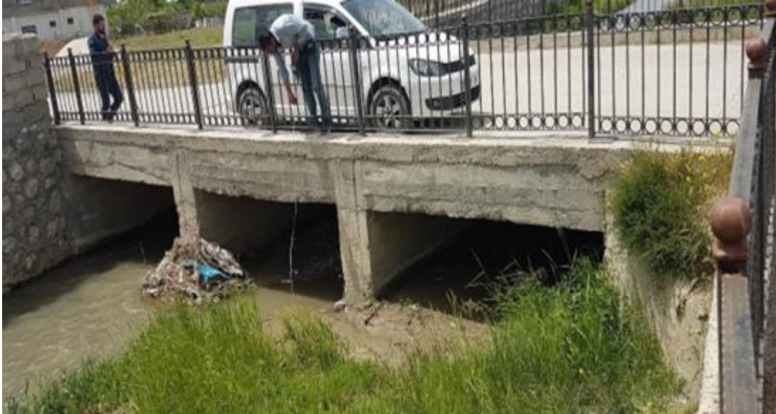
Şekil 4.17. Van Merkez6 Deresi Geçiş Yapısı
