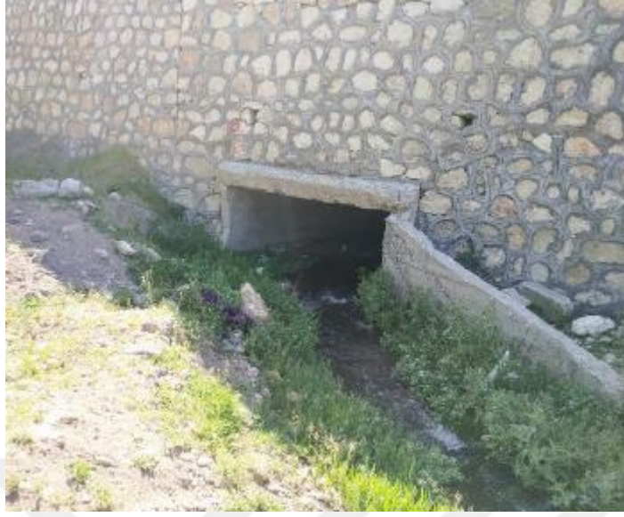
Şekil 4.32. Erciş1 Deresi Geçiş Yapısı
