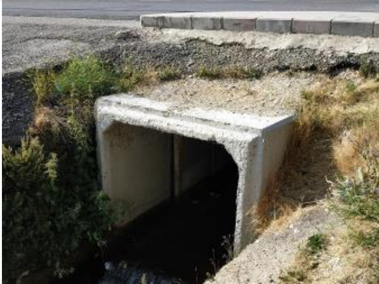
Şekil 4.75. Adilcevaz2 Deresi Geçiş Yapısı
