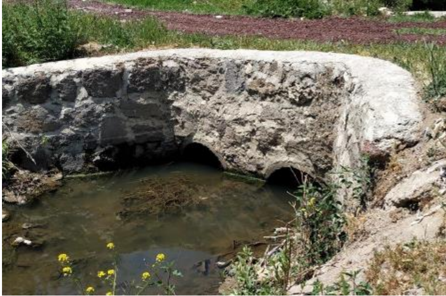
Şekil 4.55. Erciş5 Deresi Geçiş Yapısı
