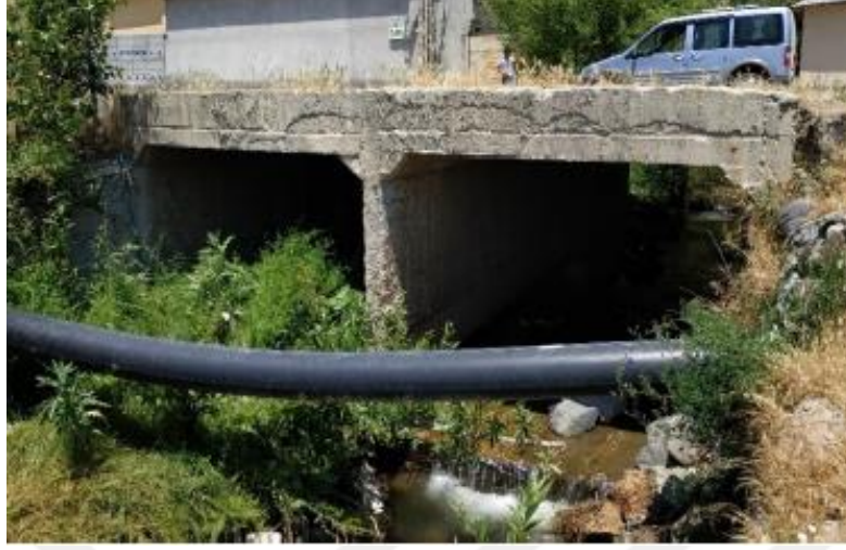
Şekil 4.80. Adilcevaz2 Deresi Geçiş Yapısı
