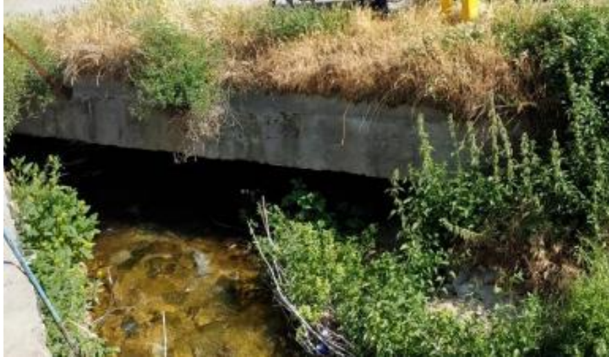
Şekil 4.77. Adilcevaz2 Deresi Geçiş Yapısı
