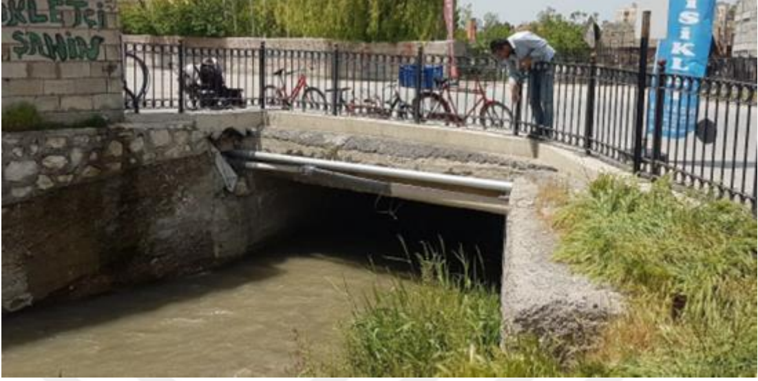
Şekil 4.18. Van Merkez6 Deresi Geçiş Yapısı
