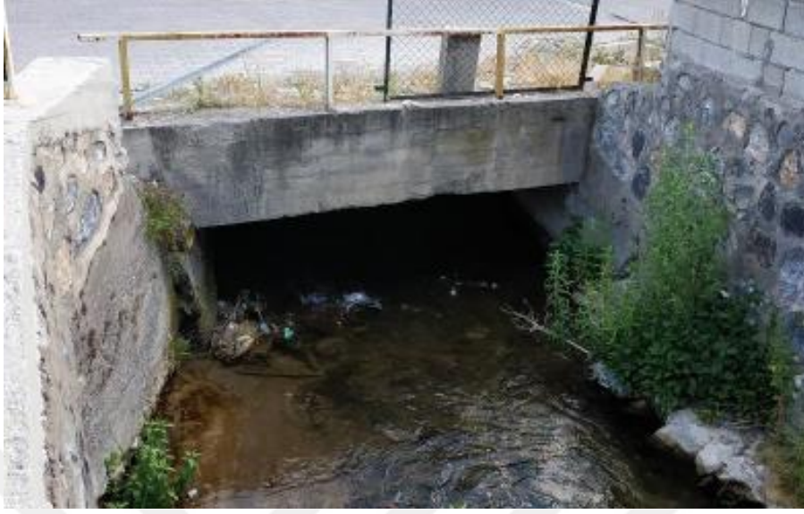
Şekil 4.76. Adilcevaz2 Deresi Geçiş Yapısı
