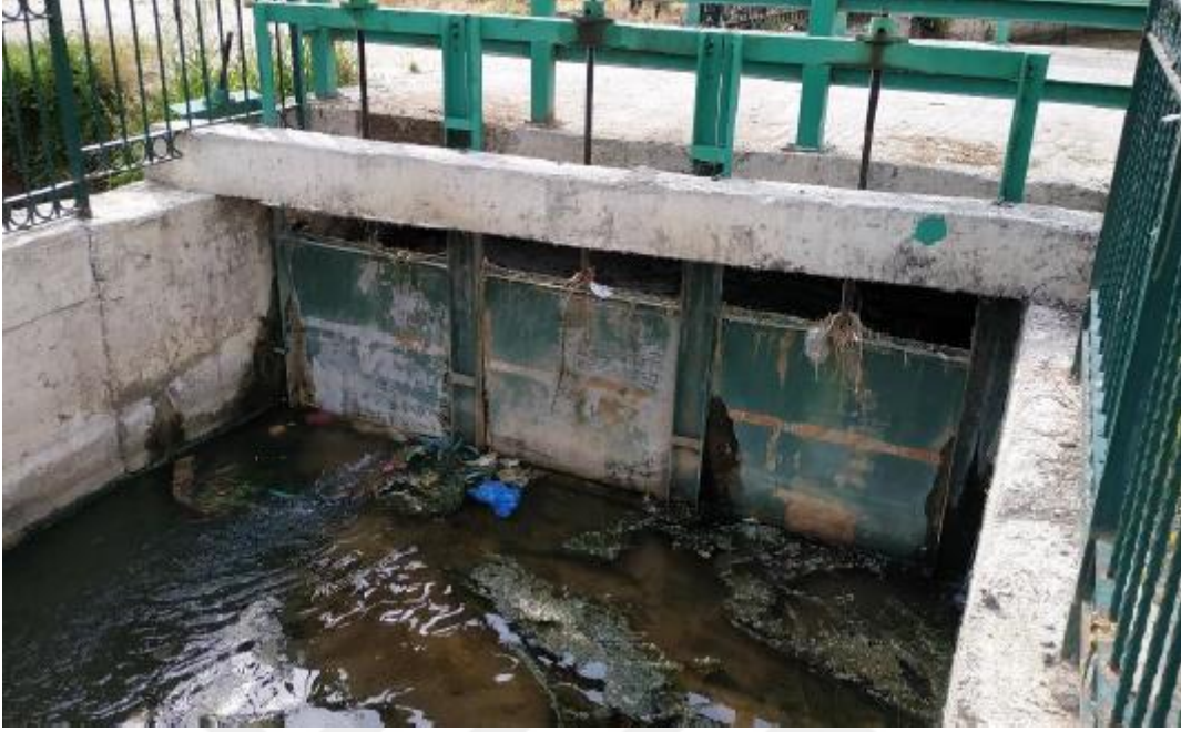
Şekil 4.60. Erciş5 Deresi Geçiş Yapısı
