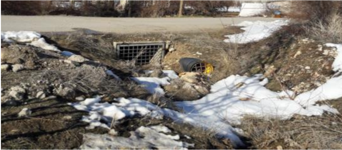
Şekil 4.65. Atalan Deresi Geçiş Yapısı
