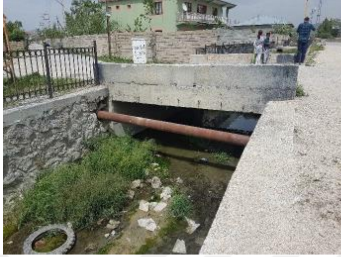
Şekil 4.6. Van Merkez2 Deresi Geçiş Yapısı
