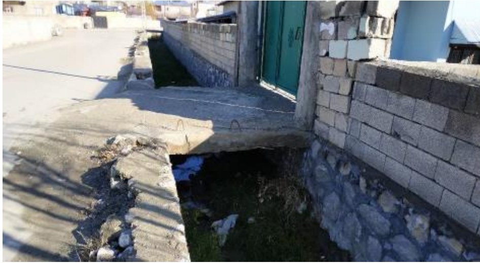
Şekil 4.11. Van Merkez2 Deresi Geçiş Yapısı
