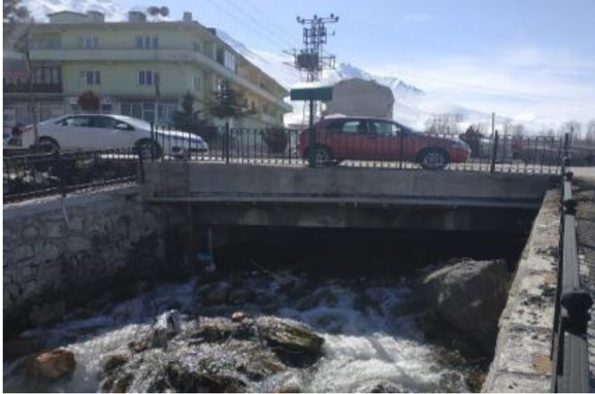
Şekil 4.67. Gevaş3 Deresi Geçiş Yapısı
