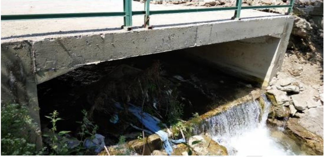
Şekil 4.78. Adilcevaz2 Deresi Geçiş Yapısı
