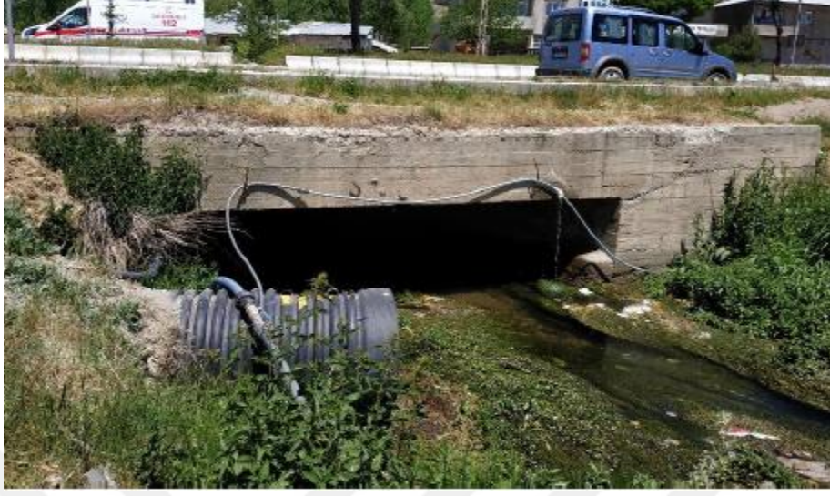
Şekil 4.48. Erciş4 Deresi Geçiş Yapısı
