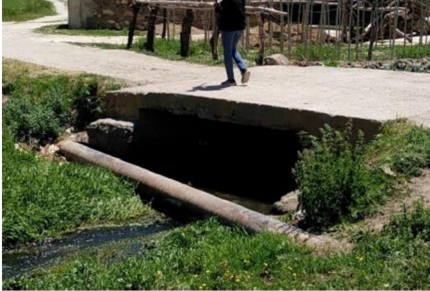
Şekil 4.49. Erciş4 Deresi Geçiş Yapısı
