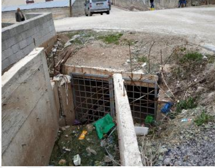
Şekil 4.72. Özalp3 Deresi Geçiş Yapısı
