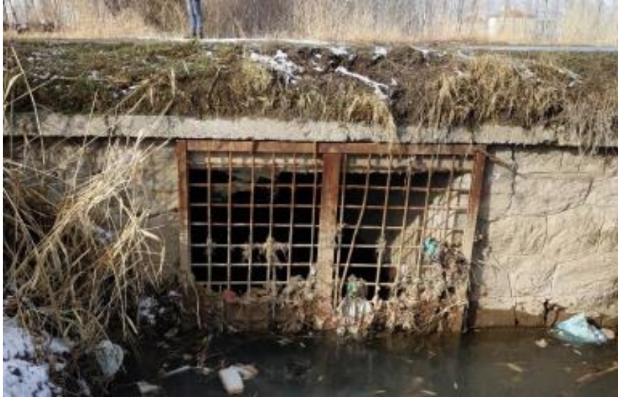
Şekil 4.85. Küçükköy Deresi Geçiş Yapısı
