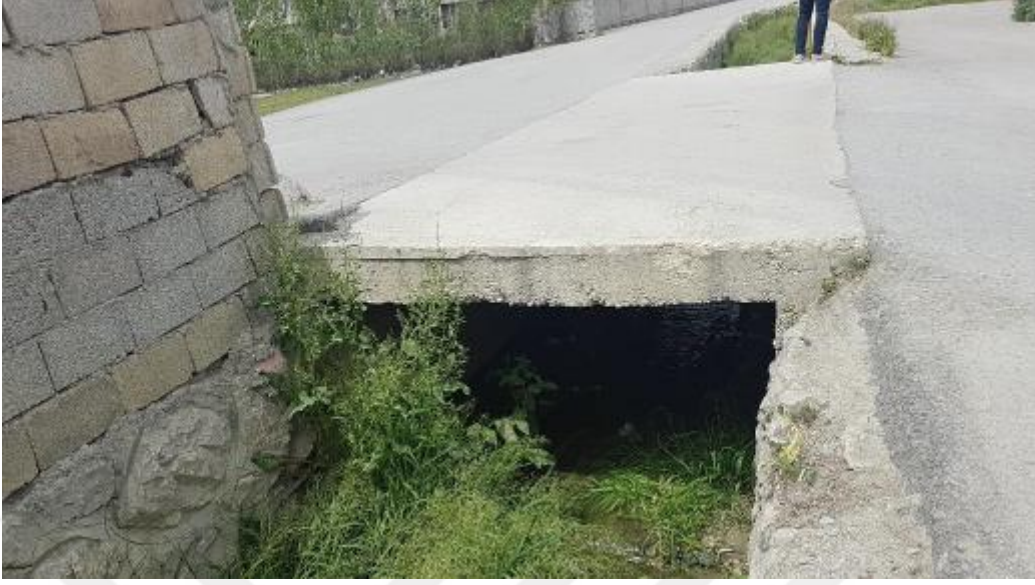
Şekil 4.10. Van Merkez2 Deresi Geçiş Yapısı
