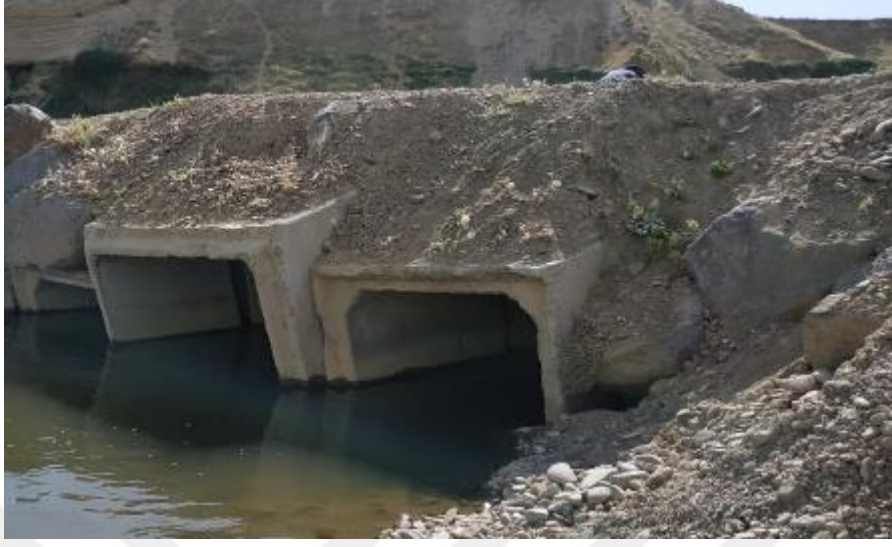
Şekil 4.38. Erciş2 Deresi Geçiş Yapısı
