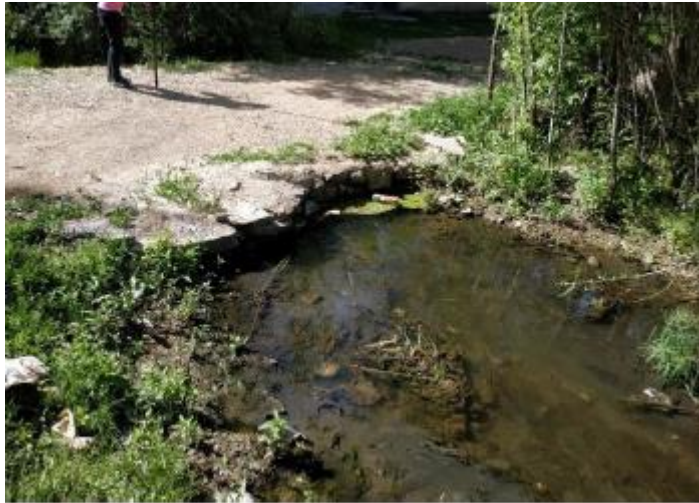
Şekil 4.31. Erciş1 Deresi Geçiş Yapısı
