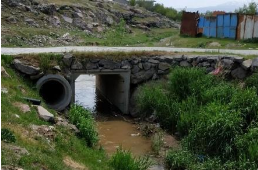
Şekil 4.83. Muradiye Deresi Geçiş Yapısı
