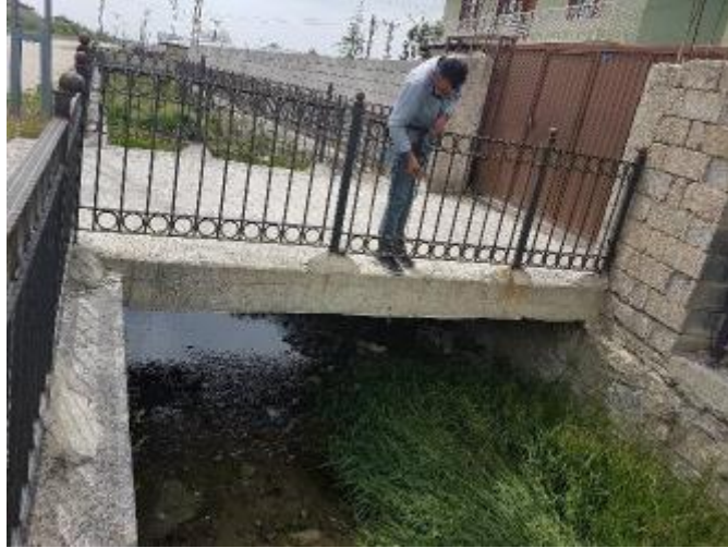
Şekil 4.7. Van Merkez2 Deresi Geçiş Yapısı
