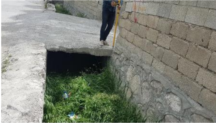
Şekil 4.9. Van Merkez2 Deresi Geçiş Yapısı
