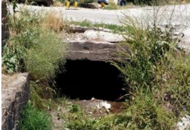
Şekil 4.87. Ahlat2 Deresi Geçiş Yapısı
