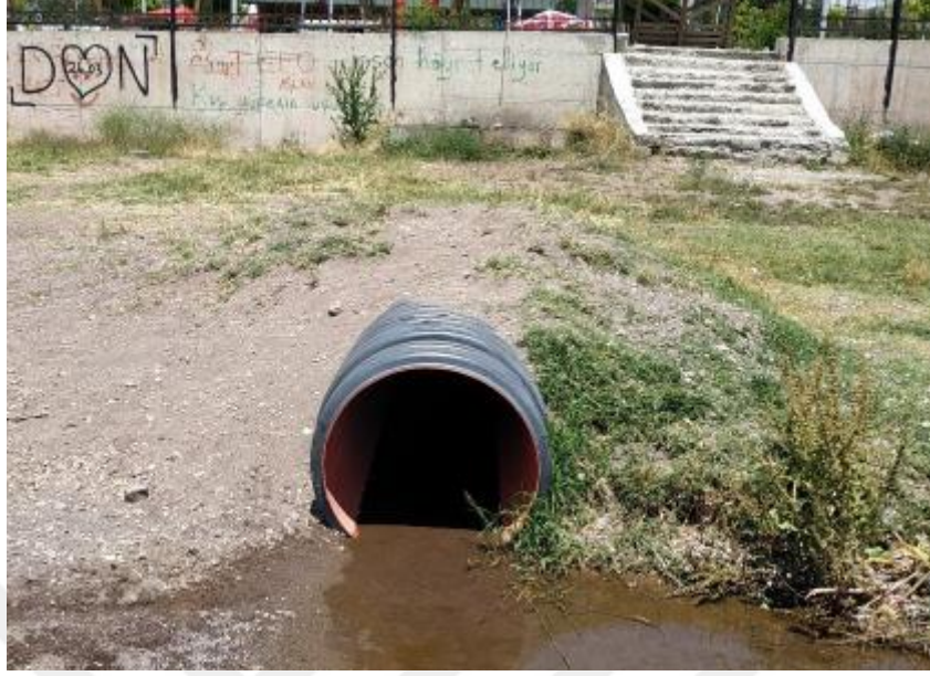
Şekil 4.86. Ahlat2 Deresi Geçiş Yapısı
