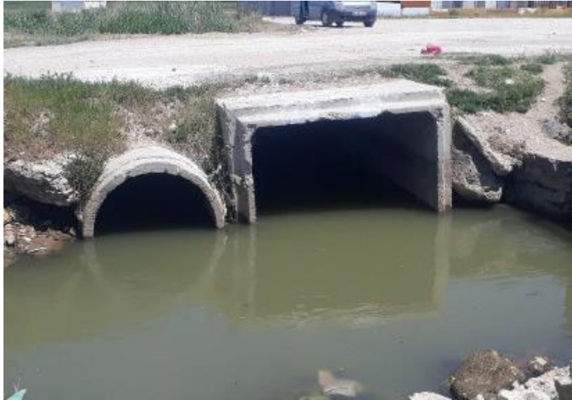
Şekil 4.47. Erciş4 Deresi Geçiş Yapısı
