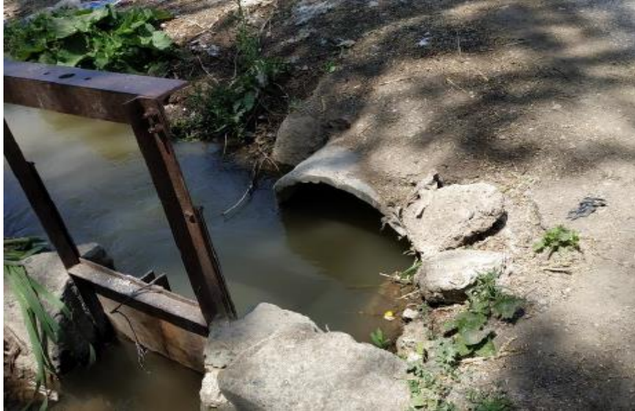
Şekil 4.57. Erciş5 Deresi Geçiş Yapısı
