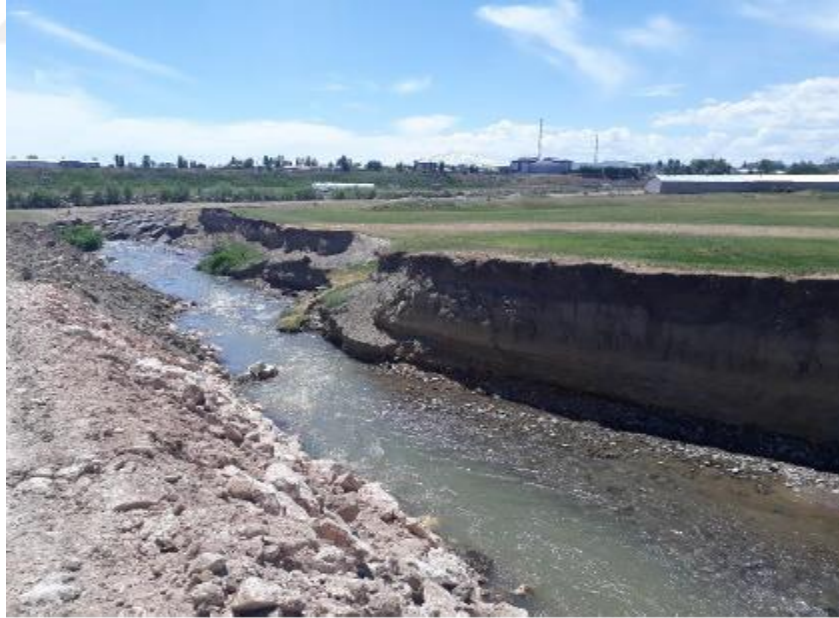
Şekil 4.41. Erciş4 Deresi Geçiş Yapısı
