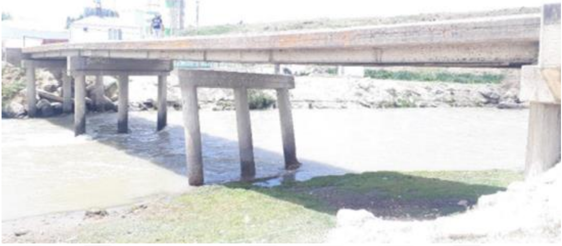
Şekil 4.40. Erciş3 Deresi Geçiş Yapısı
