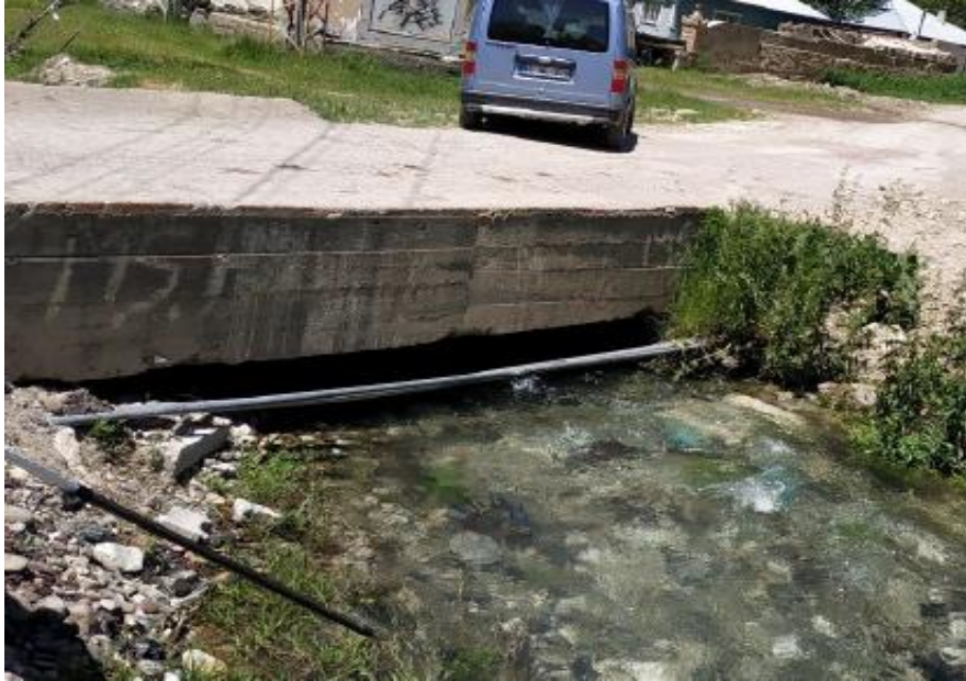
Şekil 4.51. Erciş4 Deresi Geçiş Yapısı
