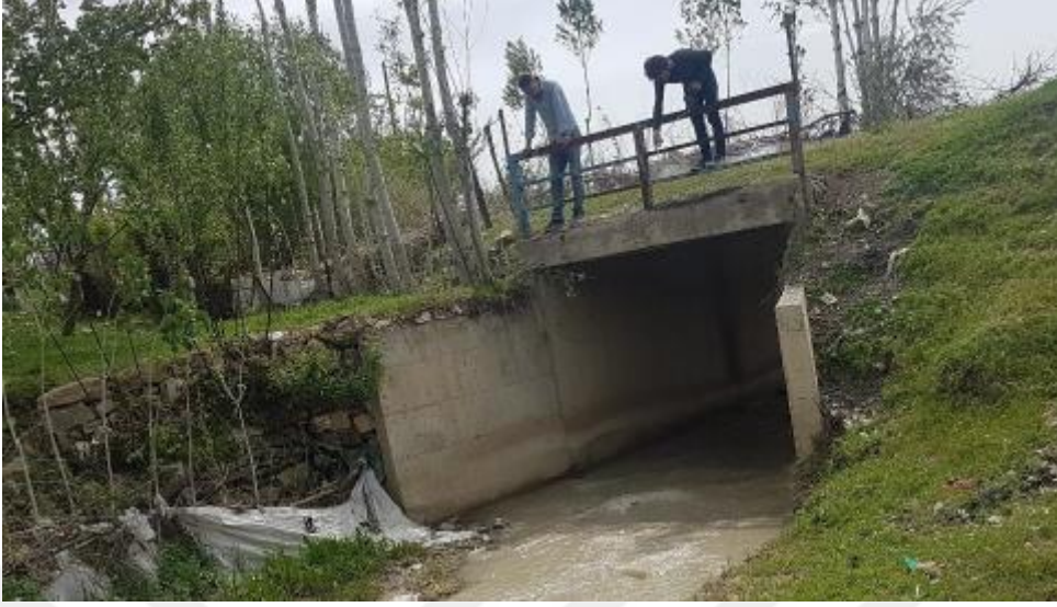
Şekil 4.22. Van Merkez6 Deresi Geçiş Yapısı
