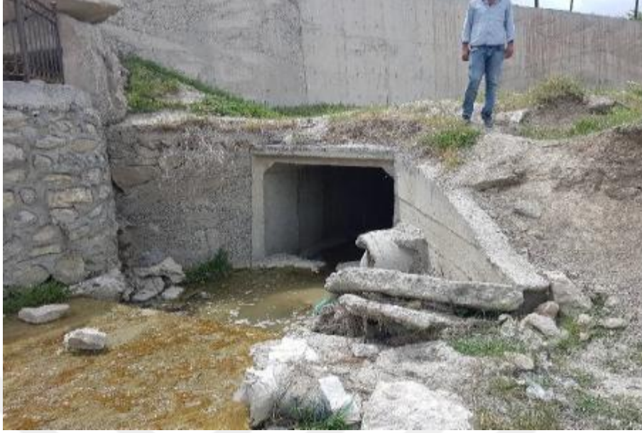
Şekil 4.4. Van Merkez2 Deresi Geçiş Yapısı Görüntüsü
