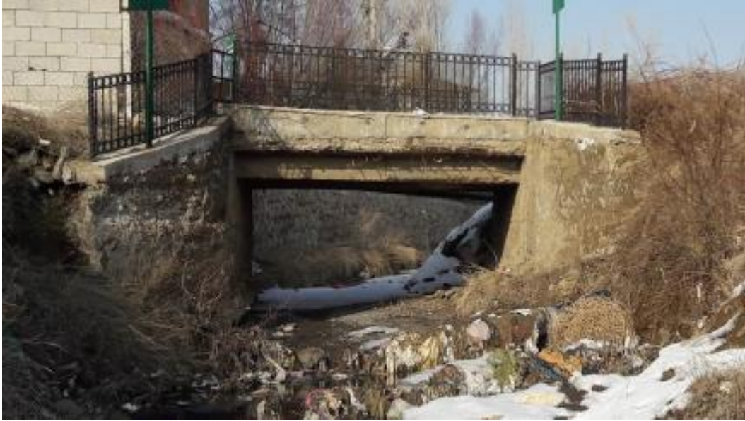
Şekil 4.19. Van Merkez6 Deresi Geçiş Yapısı
