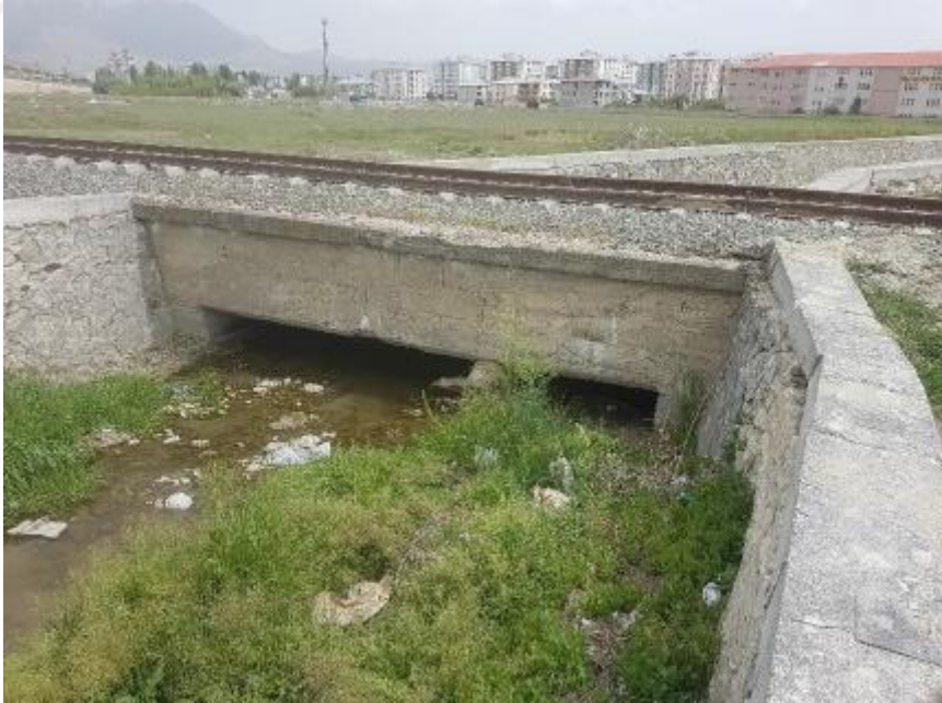
Şekil 4.5. Van Merkez2 Deresi Geçiş Yapısı Görüntüsü
