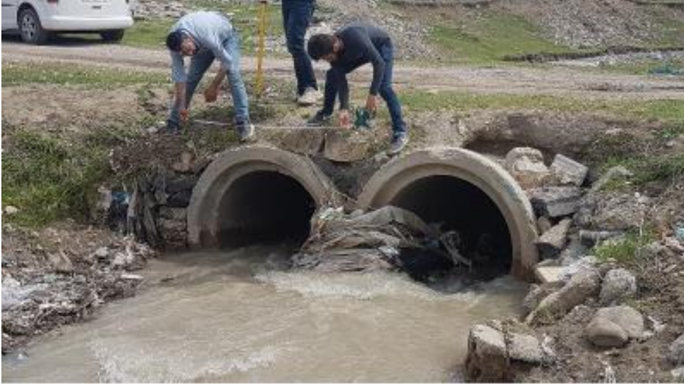
Şekil 4.21. Van Merkez6 Deresi Geçiş Yapısı
