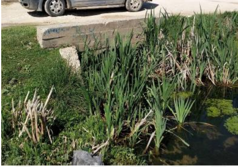
Şekil 4.36. Erciş1 Deresi Geçiş Yapısı
