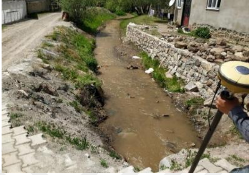
Şekil 4.82. Muradiye Deresi Geçiş Yapısı
