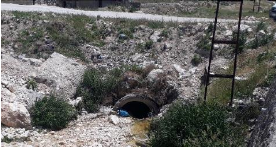
Şekil 4.61. Erciş5 Deresi Geçiş Yapısı
