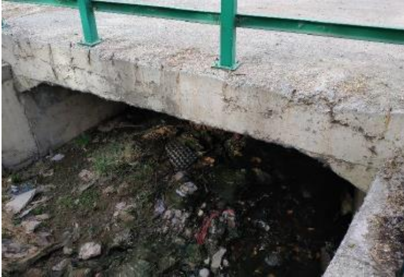
Şekil 4.59. Erciş5 Deresi Geçiş Yapısı
