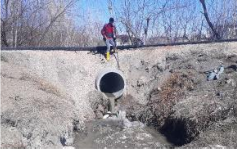
Şekil 4.13. Van Merkez3 Deresi Geçiş Yapısı
