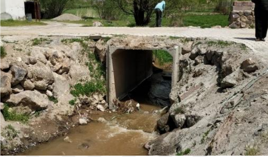
Şekil 4.84. Muradiye Deresi Geçiş Yapısı
