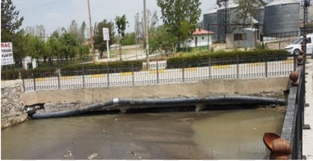
Şekil 4.16. Van Merkez6 Deresi Geçiş Yapısı
