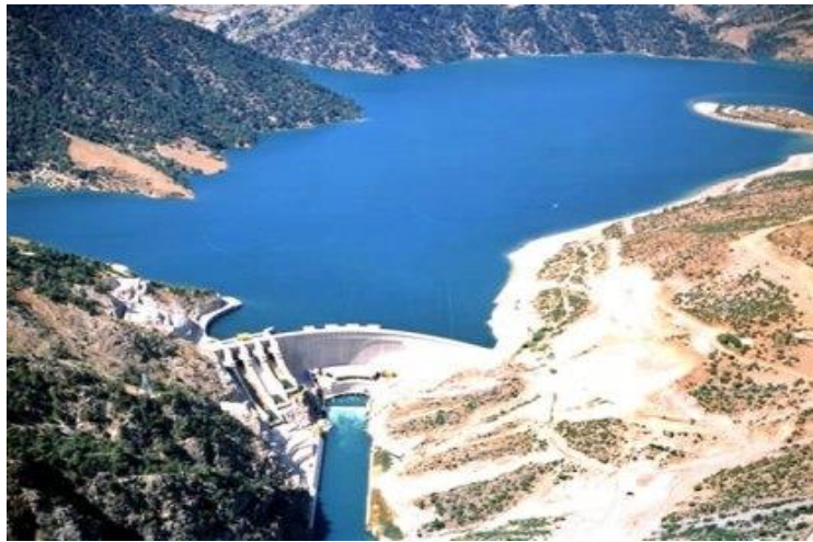
Şekil 4.5. Sır Barajı'nın görüntüsü
