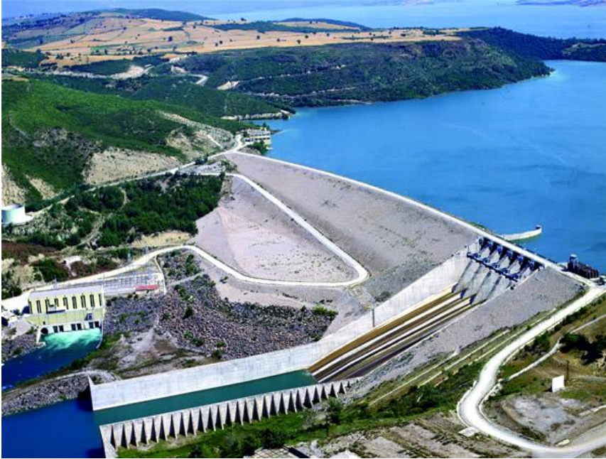
Şekil 4.7. Aslantaş Barajı'nın görüntüsü
