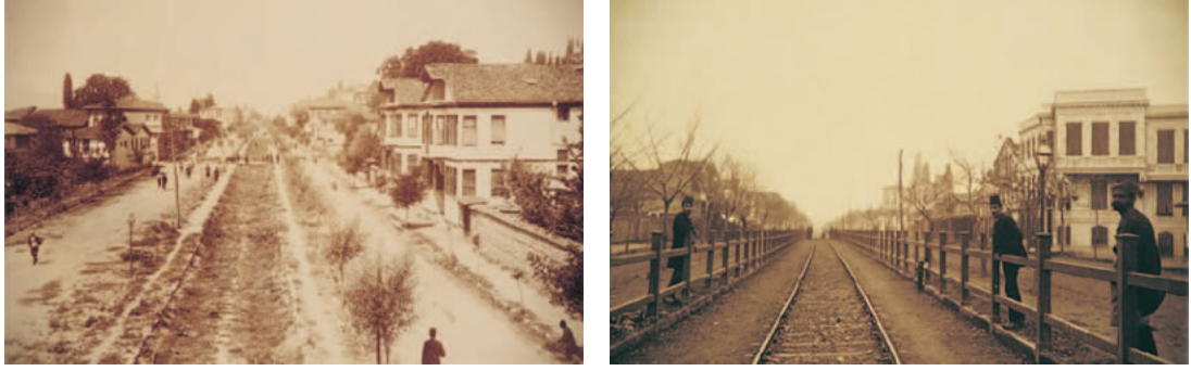
Şekil 4.9. Eski adıyla İzmir Hamidiye Caddesi, Demiryolu Caddesi'nde 1870 yılına ait olduğu tahmin edilen tren yolu yatağı çalışması (solda), tren yolu hattı tamamlandıktan sonra 1898 yılına ait bir görsel (sağda) (Usul, 1999)
