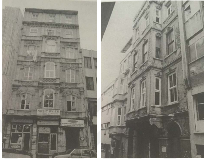
Şekil 3.4.İstanbul, Galata Bölgesinde 19. Yüzyıla ait Essayan Apartmanı (solda), Zühdi Apartmanı (sağda) (Öncel, 2014)
