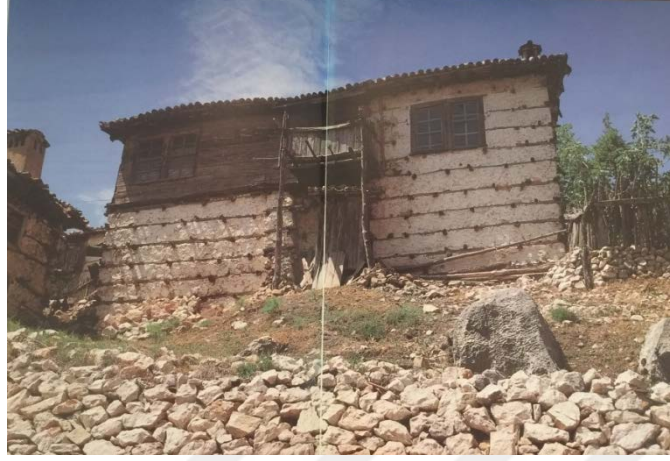
Şekil 2.9. Antalya'daki bir Türk Evinde yerel malzemelerin yapıdaki kullanımı (Sey, 1999)
