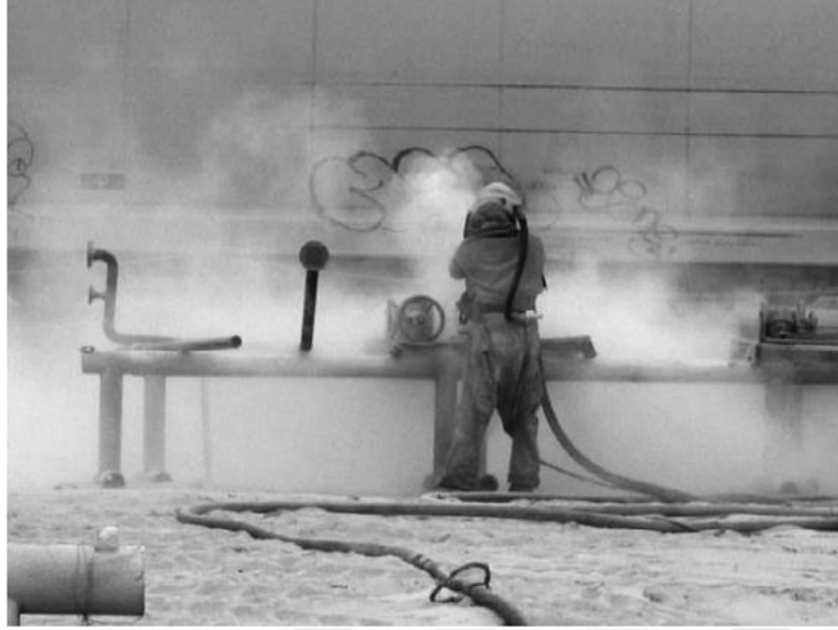
Şekil 2.7. Manuel kumlama işlemi
