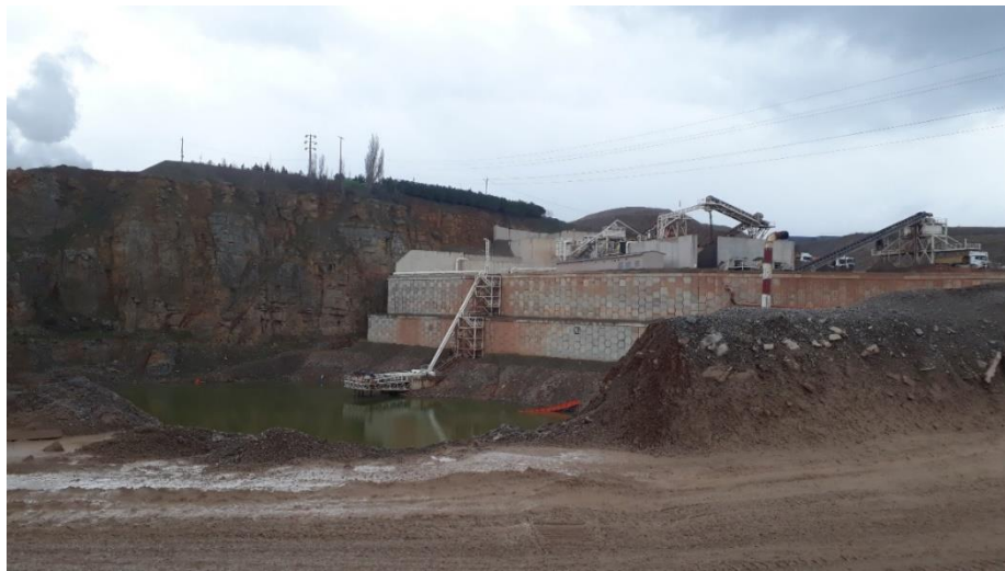
Şekil 2.2. Gebze ocağının kırma-eleme tesisi
