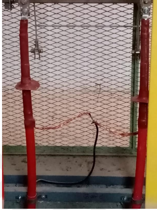
Şekil 2.5. Kablo metalik ekran toprak bağlantısı
