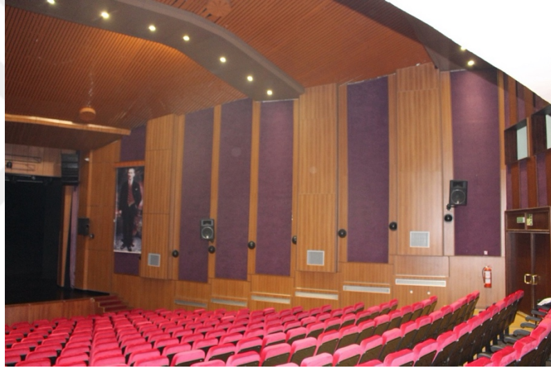
Resim 47: Salonun 2017 yılındaki renovasyondan sonra, günümüzdeki durumu. Yan duvarda yer alan yutucu yüzeylerin azaltıldığı görülmektedir.
