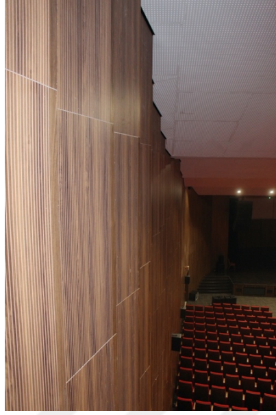
Resim 59: Akçakoca Oditoryumunun, arkası 5cm boşluklu, 5 cm taş yününden oluşan delikli yansıtıcı malzeme ile kaplanmış yan duvarı (Fotoğraf: Yazar Arşivi, 25.02.2020)
