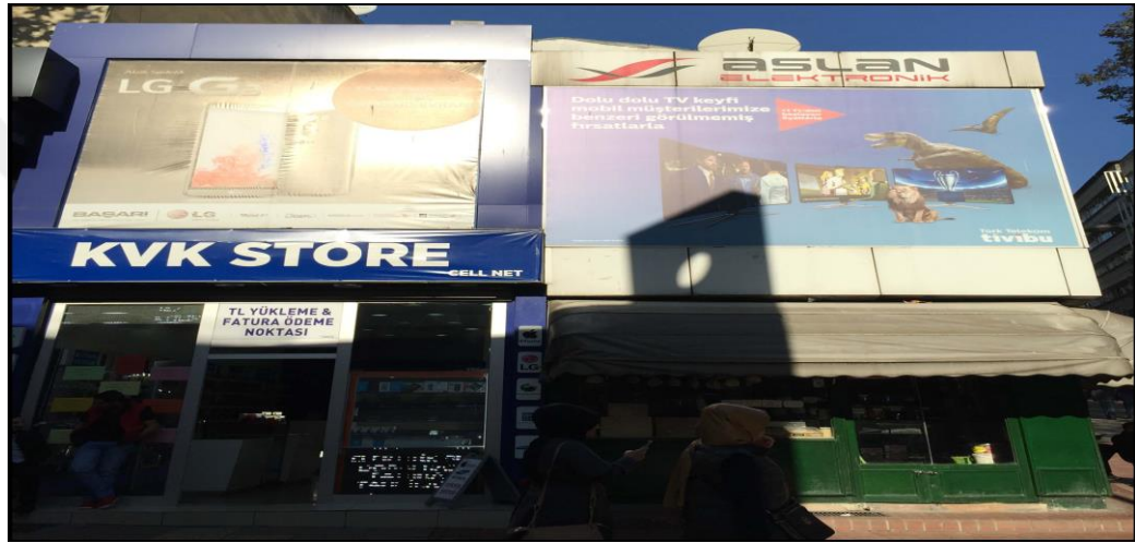
Şekil 4.4. Yangından sonra günümüze kalan kagir yapı (Yinelek 10.07.2018)
