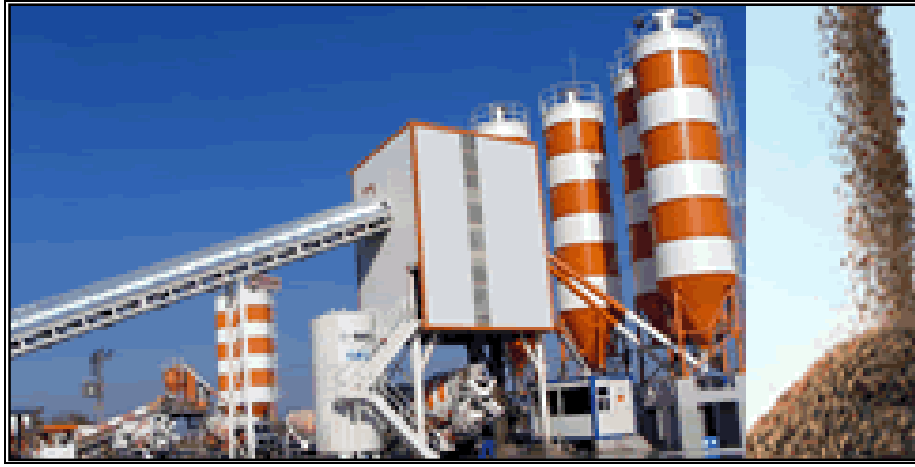
Şekil 3.12: Agreganın hazır betonda kullanımı
